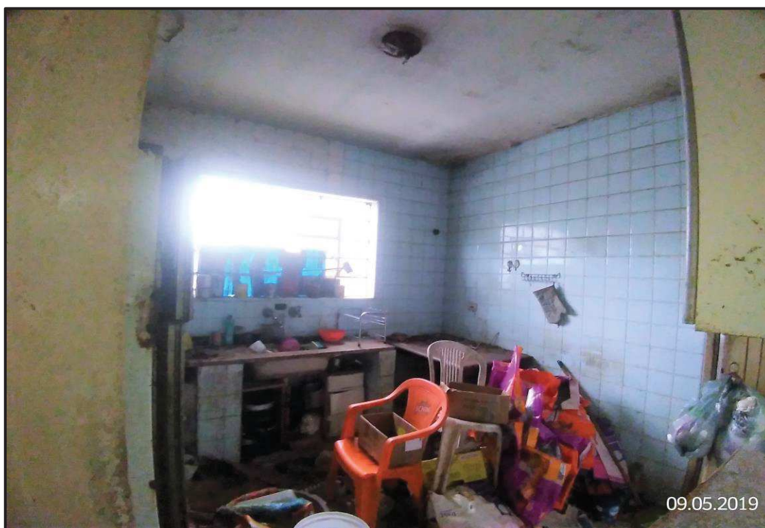
Vista da cozinha.
