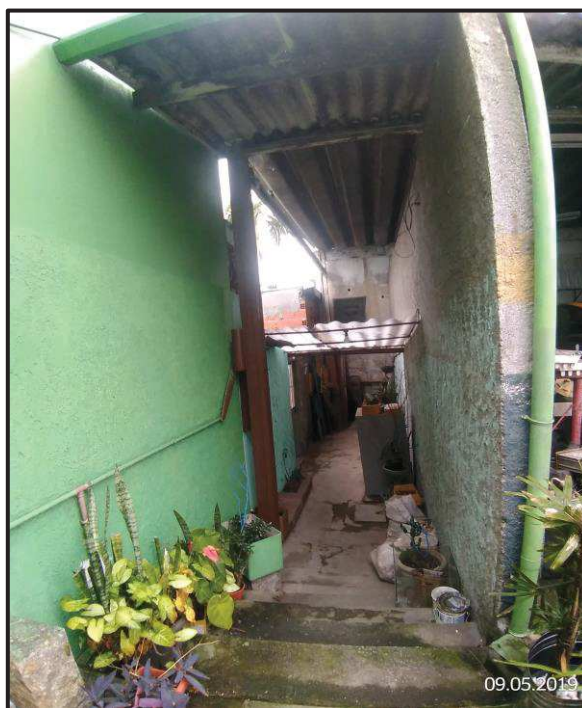
Vista do corredor de acesso dentro do imóvel avaliando para o imóvel vizinho do lado esquerdo de quem olha dos fundos.
