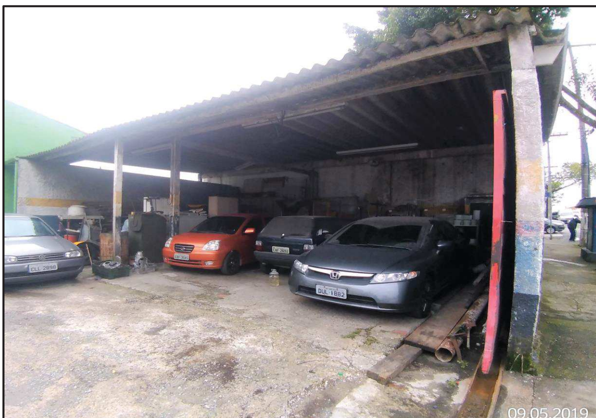
Vista da cobertura nos fundos do terreno. Essa cobertura tem acesso pelo imóvel vizinho aos fundos, mas faz parte da área do imóvel avaliando)
