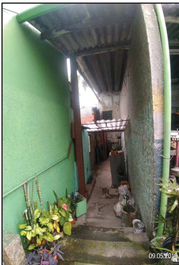
Vista do corredor de acesso dentro do imóvel avaliando para o imóvel vizinho do lado esquerdo de quem olha dos fundos.
