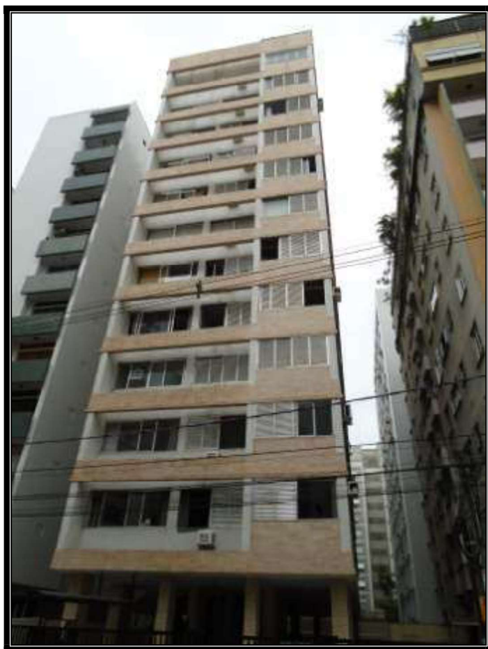
Vista do Edifício Claudia Valeria
