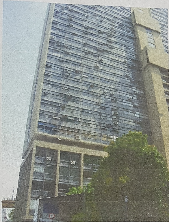
Foto 01 – Frente do imóvel avaliando, Av. Prestes Maia nº 241
