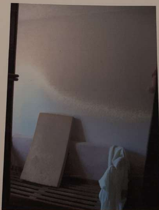
VISTA DO TERCEIRO DORMITÓRIO DO IMÓVEL OBJETO DA PRESENTE AÇÃO.
