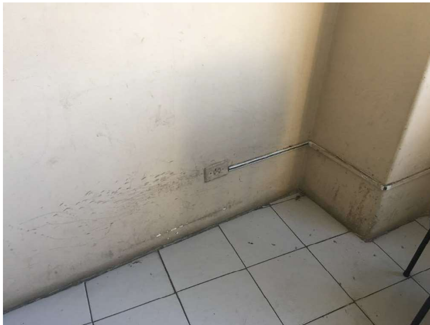
ASPECTOS GERAIS - SALA 31
