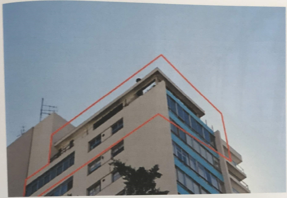
Cobertura vistoriada destaque em vermelho
