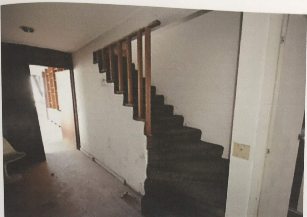
Escada de acesso ao 16° andar
