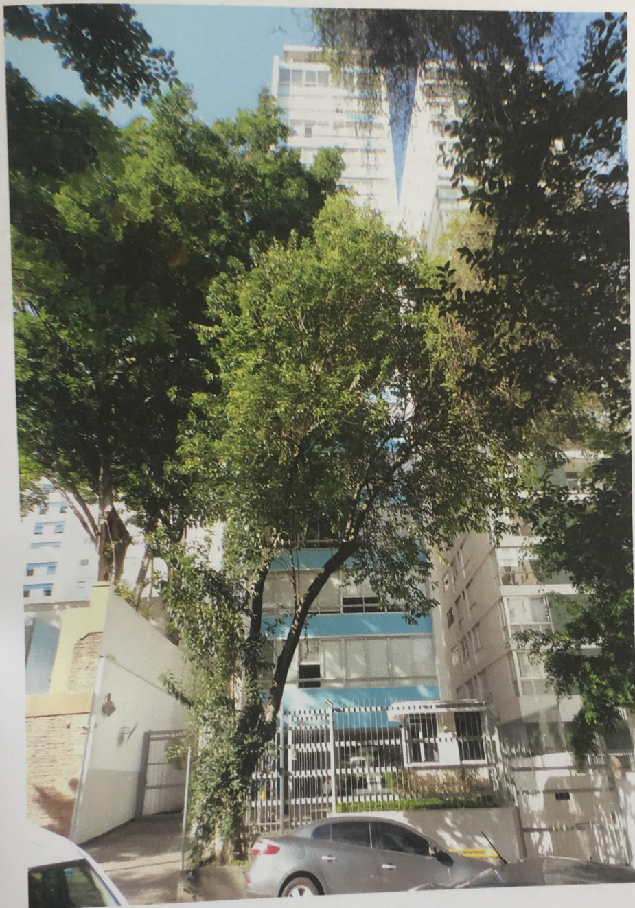
Fachada do prédio
