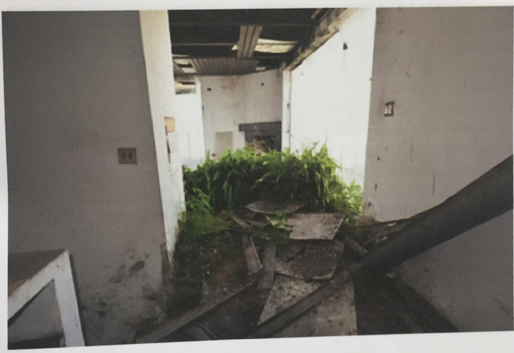
Hall do 16° andar
