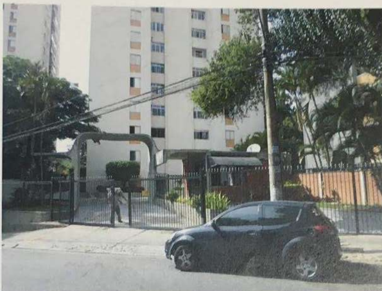
Na imagem acima, tem-se uma tomada da testada do Edifício Solar dos Flamboyant's.
