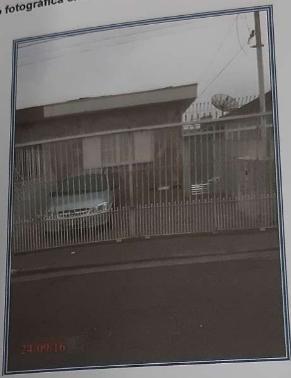
Vista da frente do imóvel avaliando.
