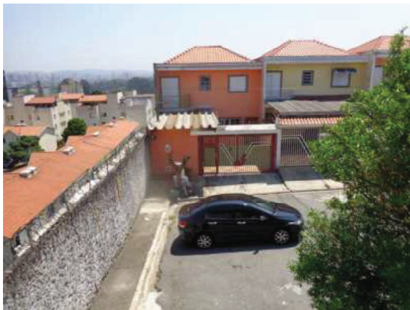
Vista da varanda
