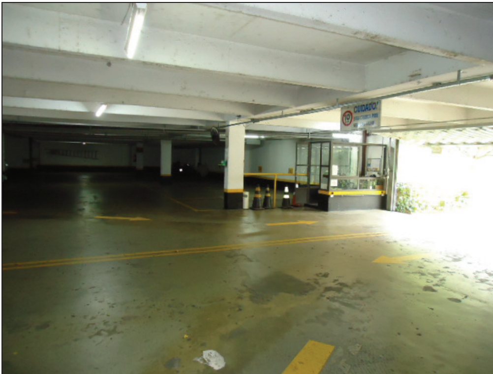
Foto 6 – Entrada da garagem, 2º subsolo do Edifício Castanheira, bloco D.
