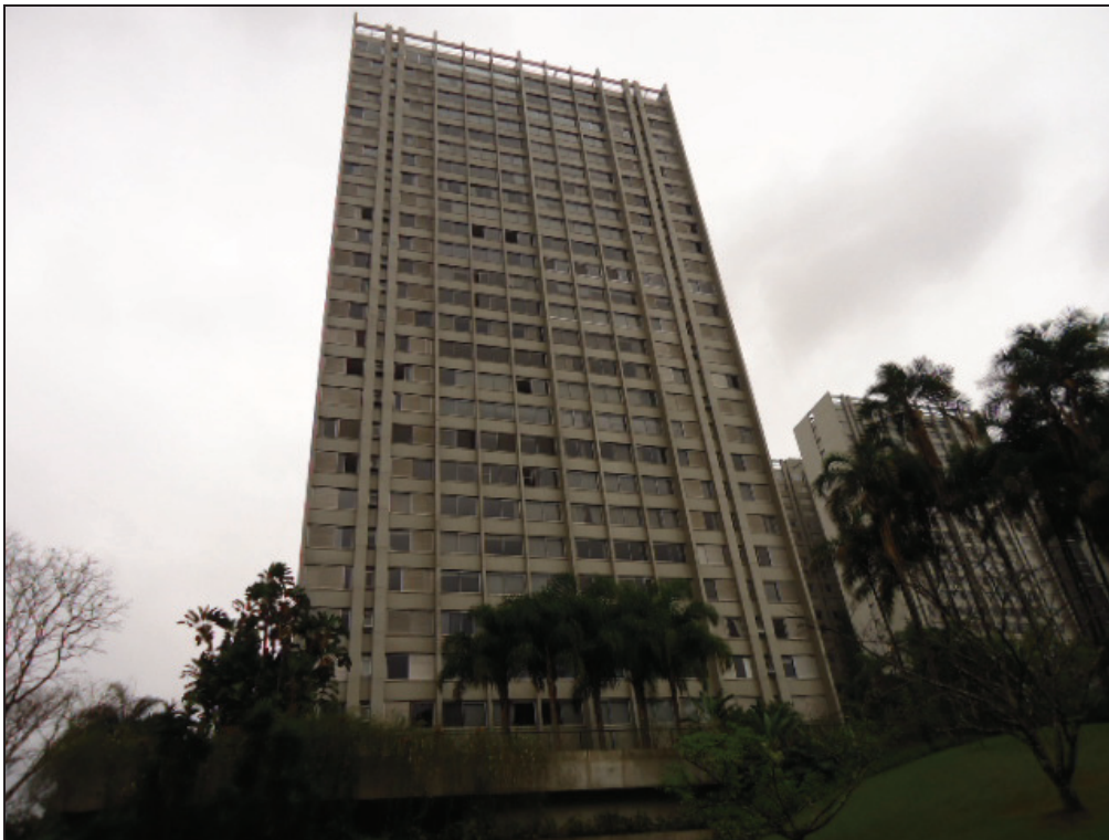
Foto 3 - Edifício Castanheira, bloco D, outra vista.
