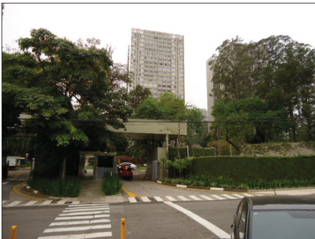
Foto 1 – Portaria de serviço do Condomínio Portal do Morumbi.
