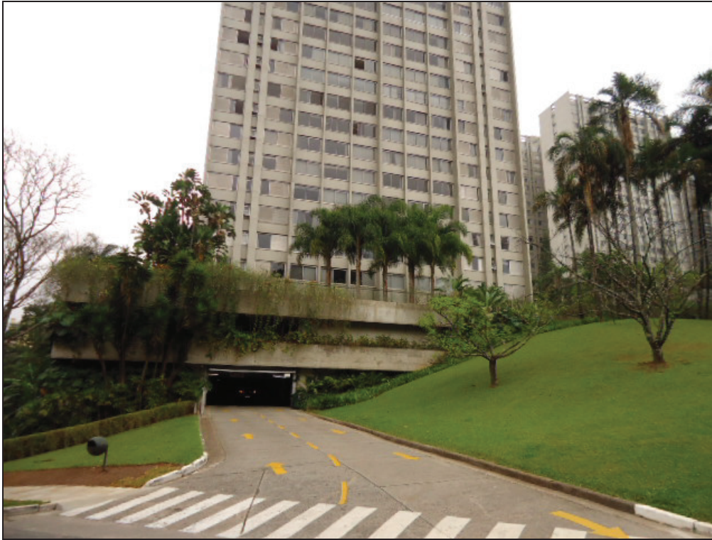
Foto 4 – Entrada para a garagem, 2º subsolo do Edifício Castanheira, bloco D.
