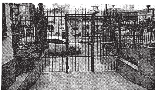
Foto 03 – Vista portão de entrada
