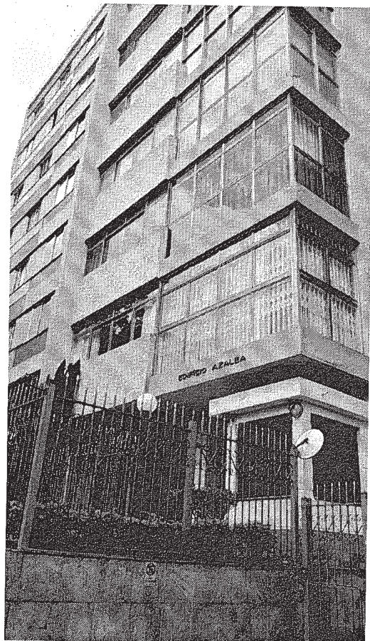
Foto 01 – Vista externa térreo condomínio
