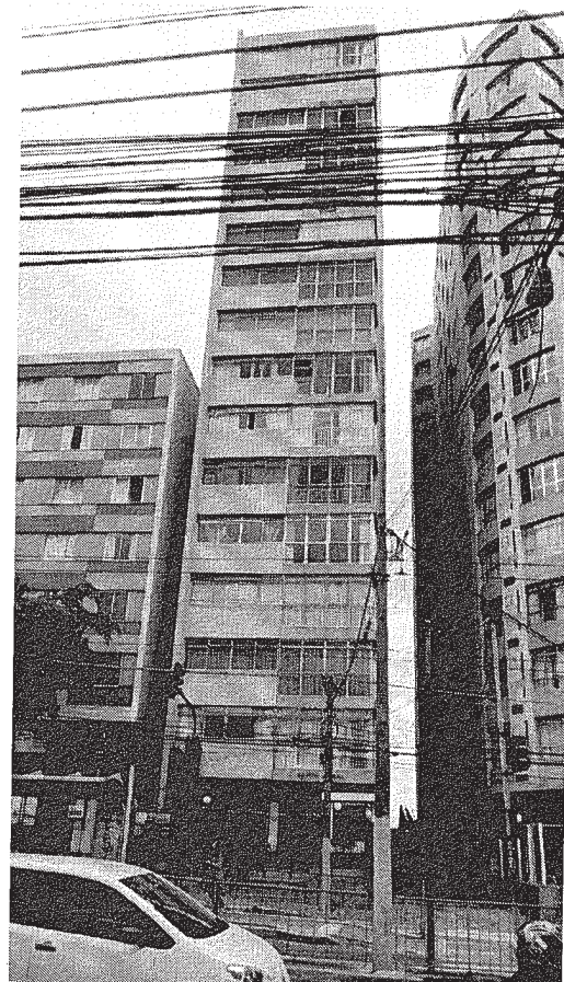
Foto 02 – Vista fachada geral
