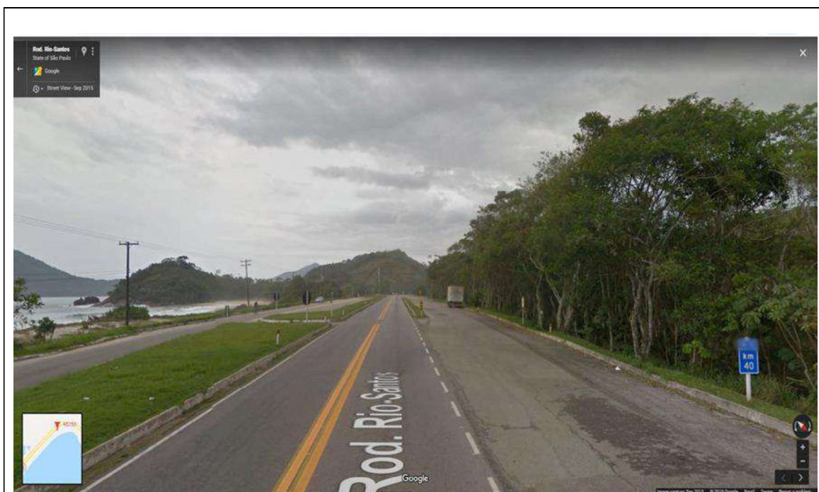
FOTO 01 – Vista geral do imóvel
