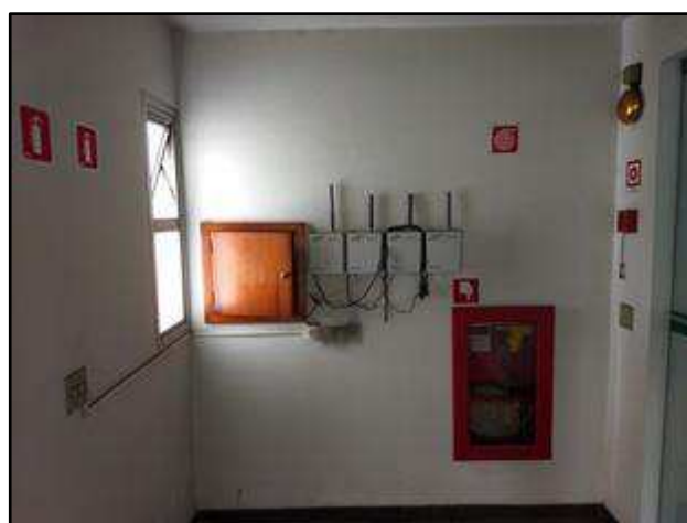
Foto 124 – Hall no 4º pavimento.
