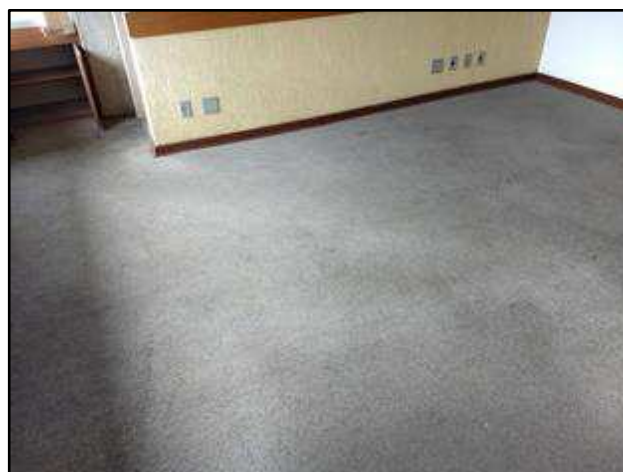
Foto 92 – Escritório 2 no 3º pavimento.
