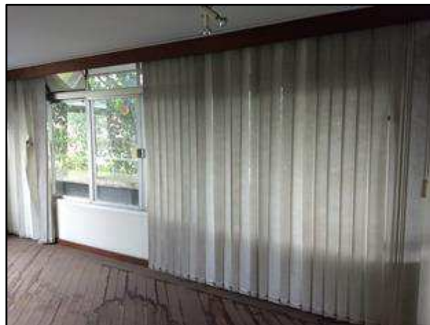
Foto 120 – Escritório 3 no 4º pavimento.
