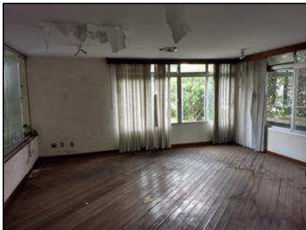
Foto 119 – Escritório 3 no 4º pavimento.
