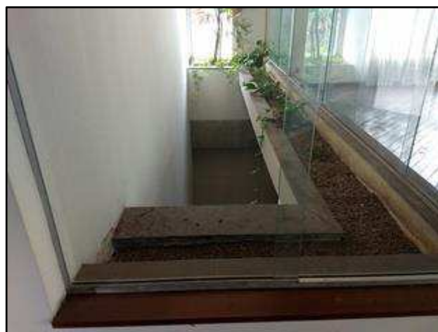
Foto 122 – Escritório 3 no 4º pavimento.
