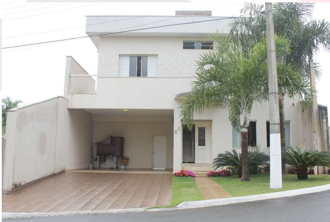
VISTA DA FACHADA DO IMÓVEL AVALIANDO.
