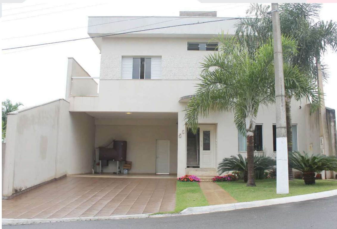
VISTA DO IMÓVEL AVALIANDO
