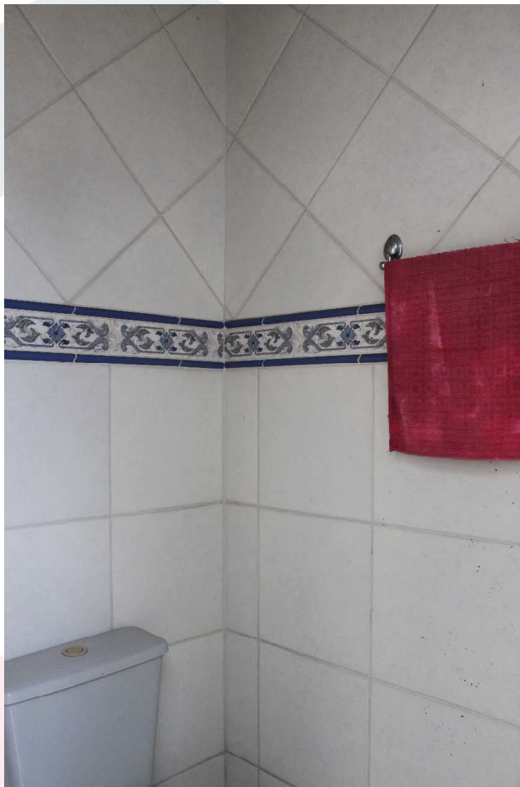
VISTA DO BANHEIRO DA PISCINA.
