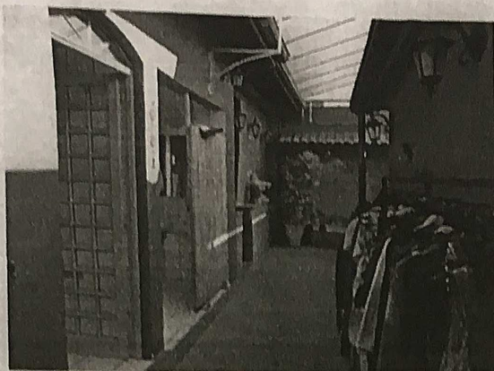
FOTO Nº 11 Vista parcial do quintal – fundos do imóvel
