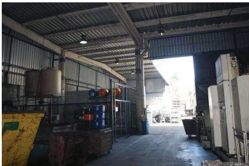
Detalhes de acabamento e conservação do interior do Galpão 4, anexo ao Galpão 1.
