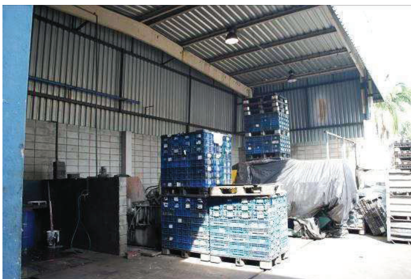
Aspectos da área externa do Galpão 4.
