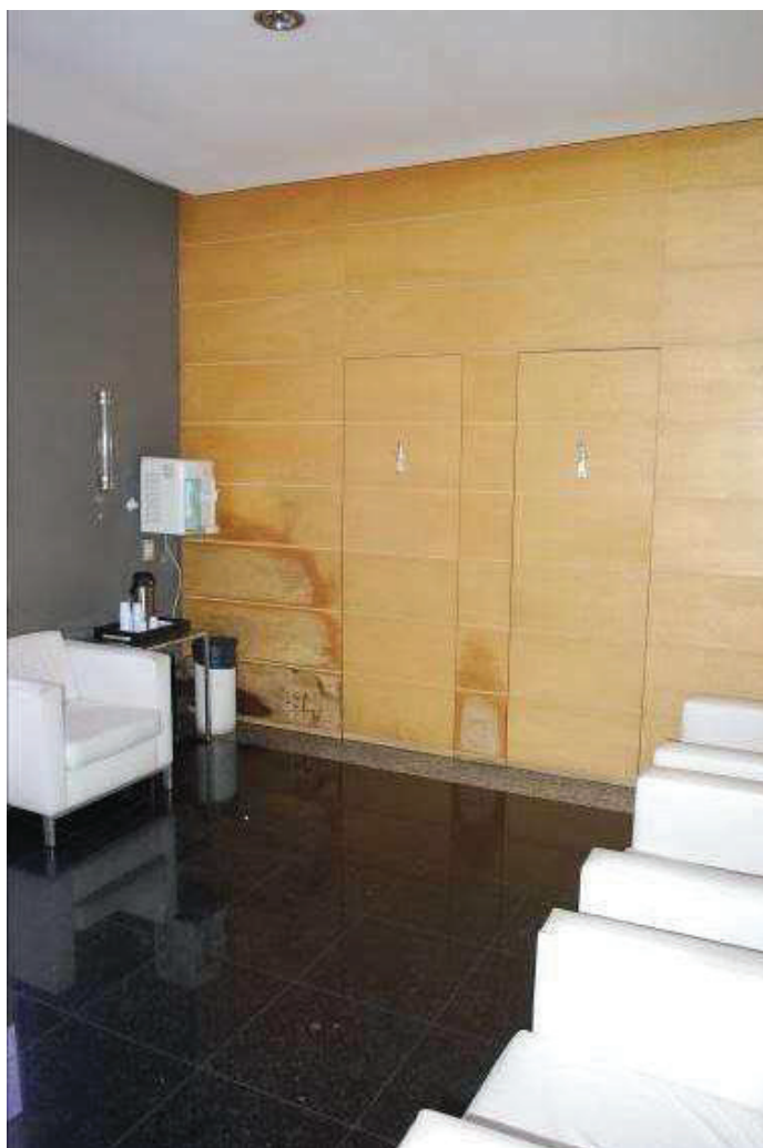
Detalhes de acabamento e conservação do interior da recepção.
