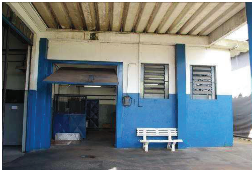
Fachada do prédio da manutenção.
