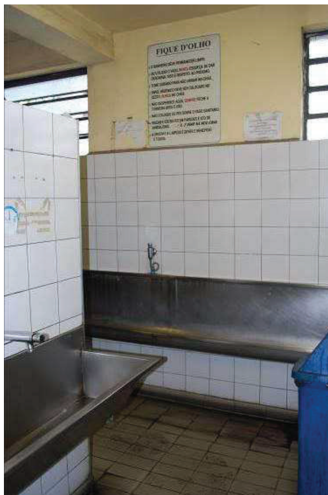
Detalhes de acabamento e conservação do banheiro.
