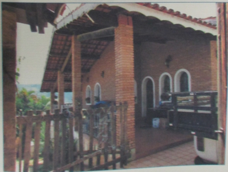
ASPECTOS DO IMÓVEL
