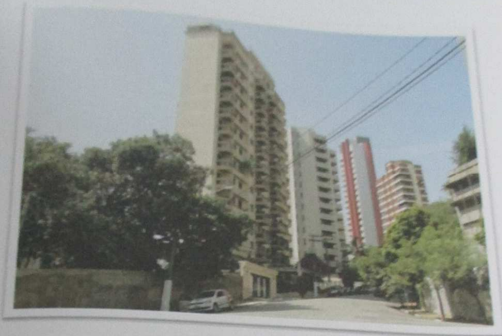
Foto nº 2 - Vista da via em tela e do Edifício Villa Régio.
