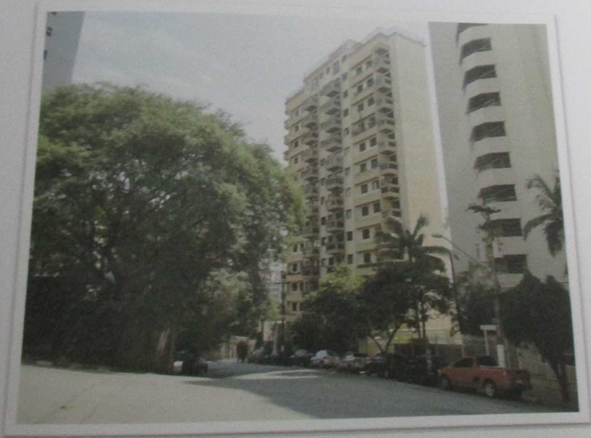
Foto nº 3 - Vista do Edifício Villa Régio no sentido oposto ao da fotografia acima.
