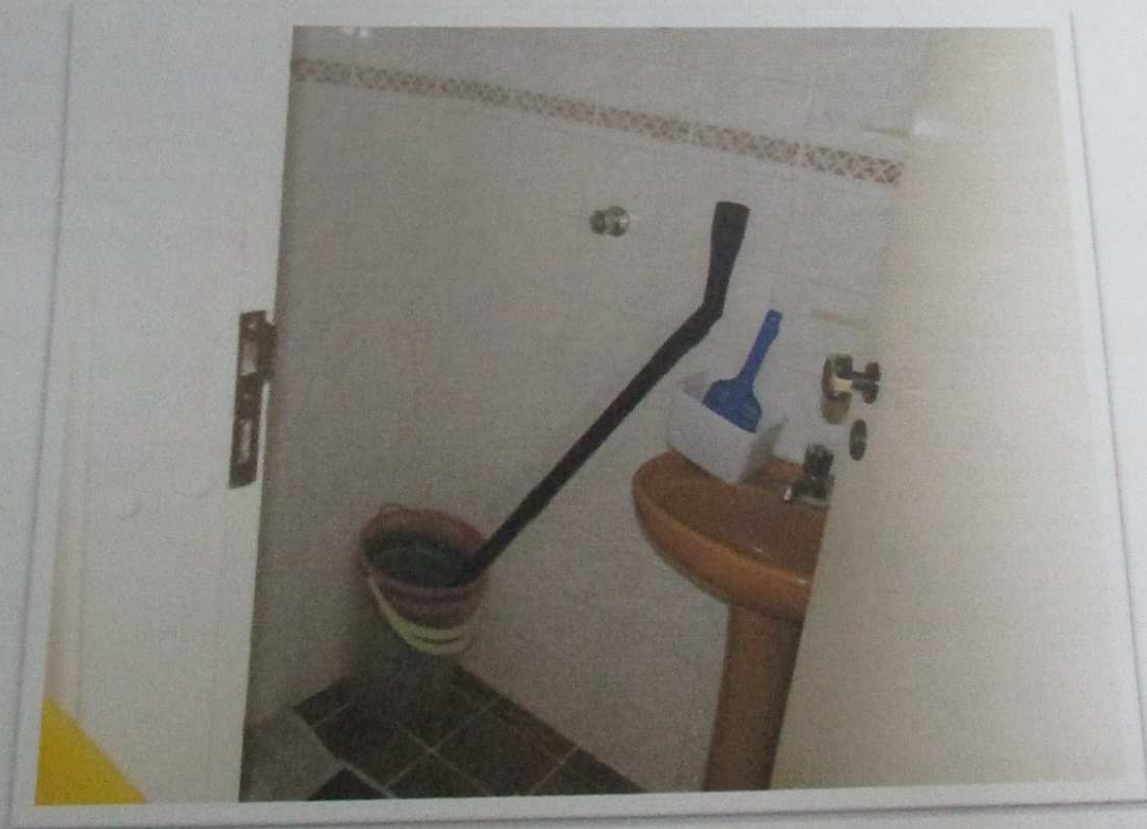
Foto nº 27 - Vista parcial do WC de empregada.
