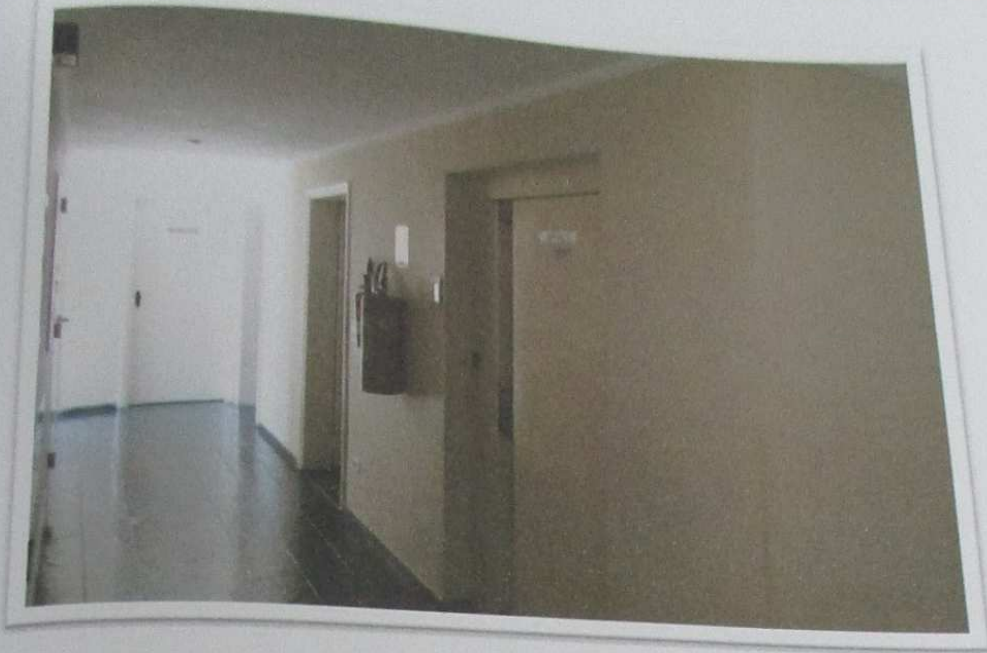
Foto nº 6 - Vista parcial do hall do elevador de serviço no pavimento térreo do prédio.
