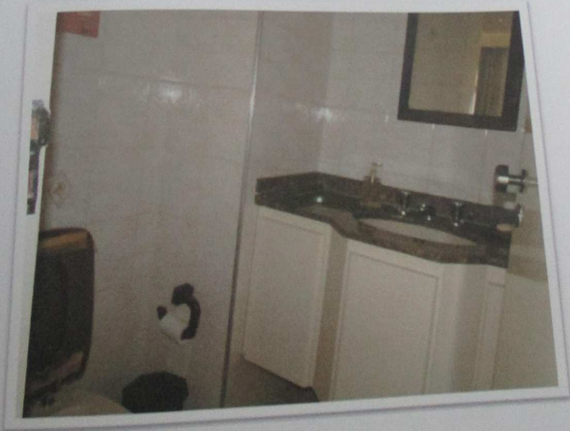
Foto nº 13 - Vista parcial do lavabo.
