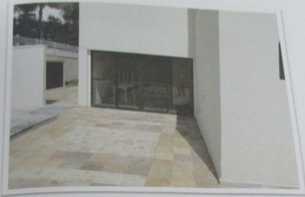
Foto nº 8 - Vista pelo lado externo do salão de festas do prédio.
