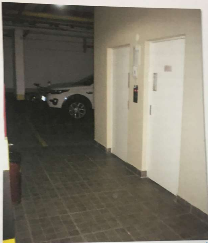
Foto nº 11 – Hall dos elevadores do subsolo.
