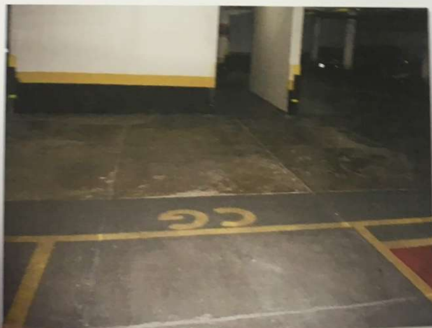
Foto nº 9 – Vaga e circulação da garagem.
