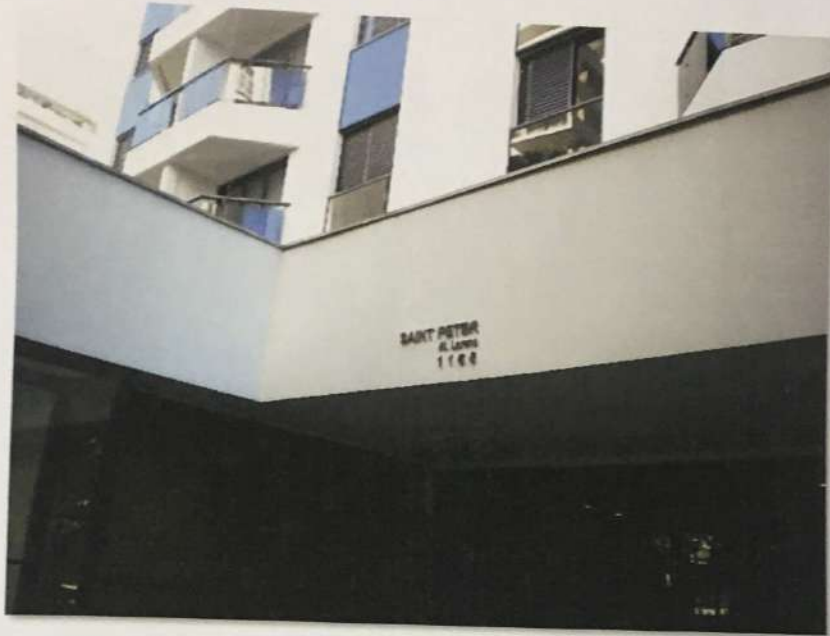
Foto nº 5 – Entrada e identificação do imóvel.
