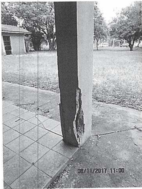
Detalhe coluna com fissura e ferragem exposta
