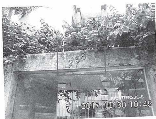
Identificação nº 758 – Edifício Relíquia
