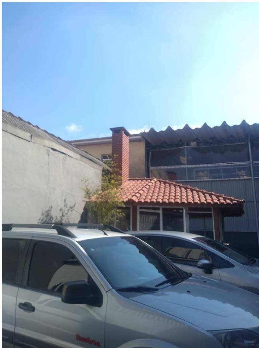
FOTO 6: VISTA INTERNA DA ÁREA;
