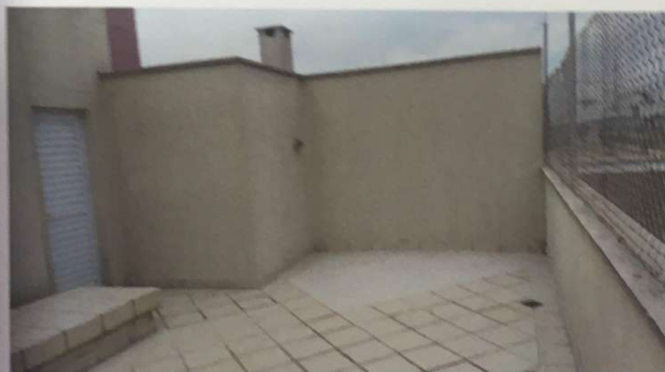
Foto 12 – Solário na cobertura do prédio.
