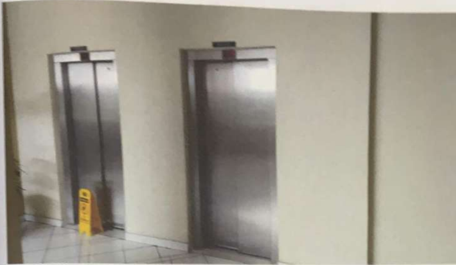
Foto 7 – Elevadores social e de serviço.
