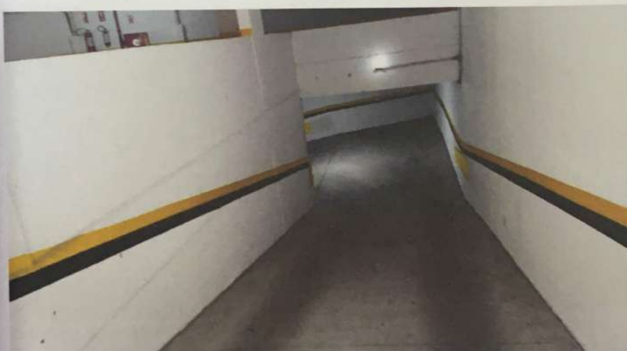
Foto 10 – Rampa para as vagas de estacionamentos dos subsolos 1 e 2.
