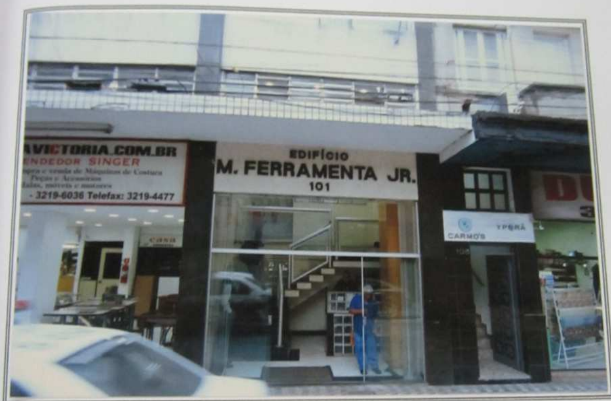
FOTO 04 - Vista do acesso para o Condomínio Edifício M. Ferramenta.
