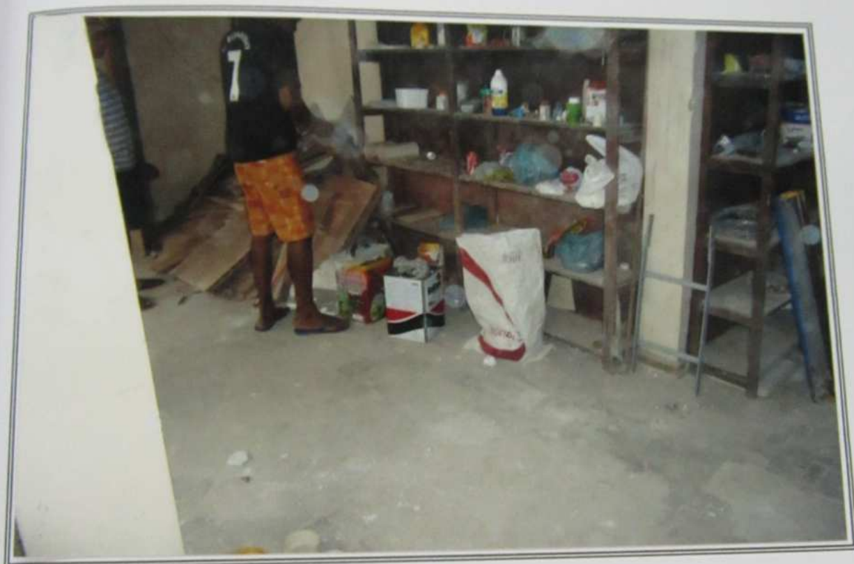
FOTO 05 - Vista parcial do conjunto. Suas principais características construtivas são: piso em taco, paredes revestidas em massa pintadas em látex, forro em laje e esquadrias de ferro.
