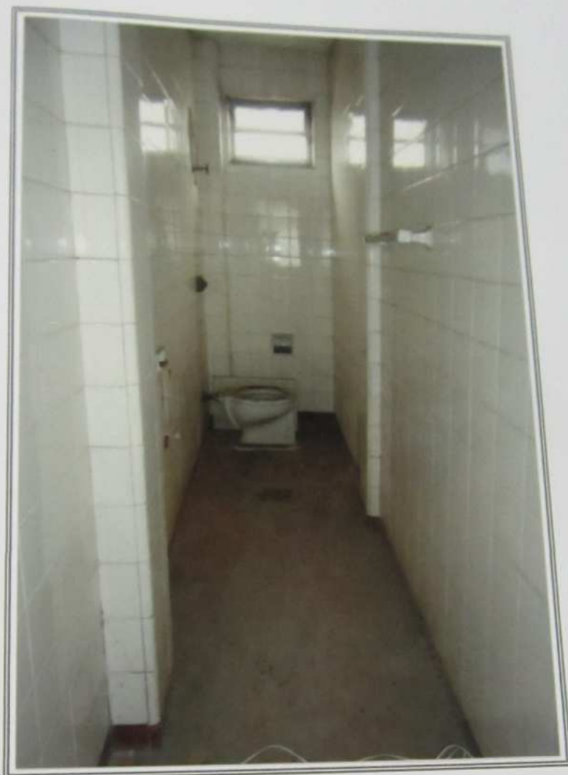
FOTO 07 - Vista do banheiro. Suas principais características construtivas são: piso em cerâmica, paredes azulejadas até o teto, forro em laje e esquadrias de ferro.
