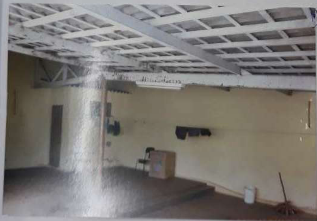
Ilustrações do Imóvel - Processo nº 925/2.008-2º Vara - Rua Augusto de Carvalho, nº 331.
