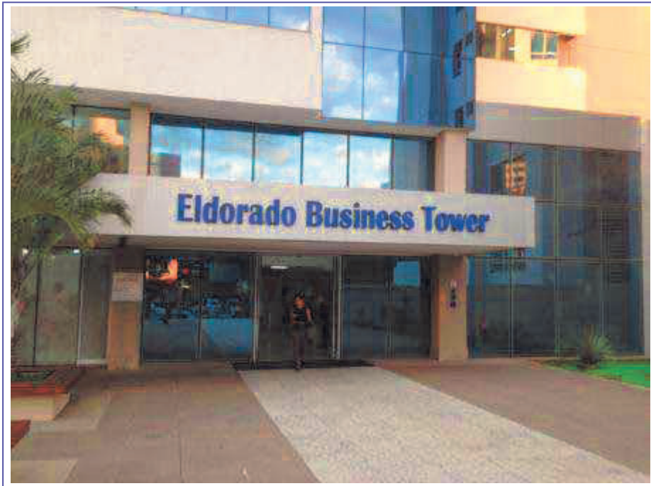
ENTRADA DO EDIFÍCIO
