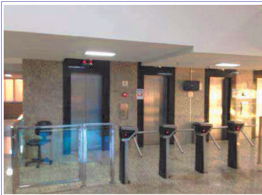
HALL DOS ELEVADORES NO TÉRREO
