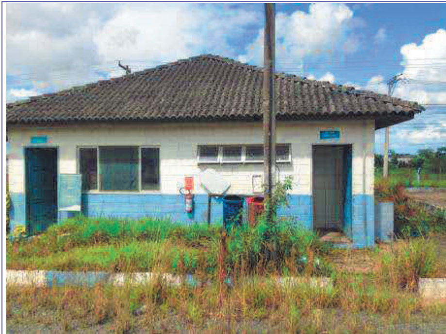
REFEITÓRIO E VESTIÁRIO
