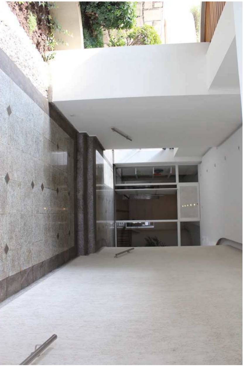
Rua Barão do Triunfo, 1.302 (Condomínio Mansão Cavivuna) – Entrada Social
