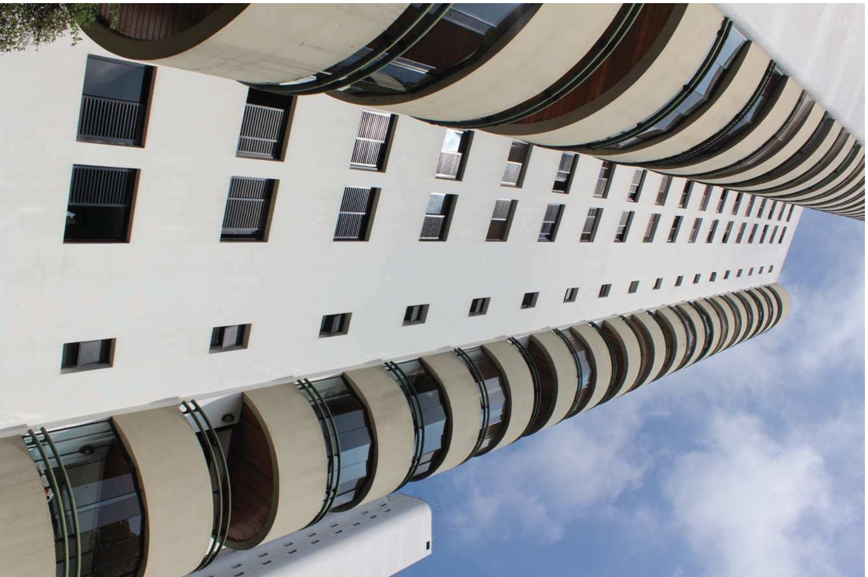
Rua Atibaia, 588 - Ap. 101(Condomínio Edifício Piazza di Treviso) – Fachada Lateral
