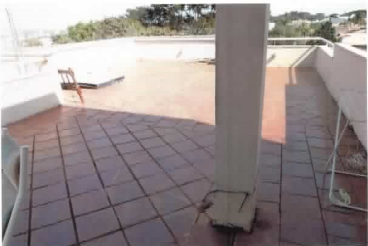
FOTO- 11 – VISTA EXTERNA DA COBERTURA DO APARTAMENTO Nº 12, MATRICULA Nº 31.251. DESTAQUE PARA ÁREA DE LAZER E PISO COM E REVESTIMENTO CERÂMICO. DATA: 27 DE MAIO DE 2019.
