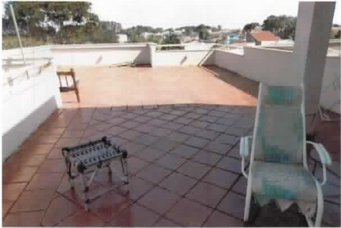
FOTO- 12 – VISTA EXTERNA DA COBERTURA DO APARTAMENTO Nº 12, MATRICULA Nº 31.251. DESTAQUE PARA ÁREA DE LAZER E PISO COM E REVESTIMENTO CERÂMICO. DATA: 27 DE MAIO DE 2019.
