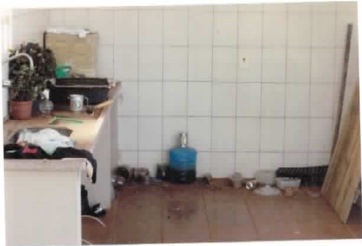
FOTO- 15 - VISTA EXTERNA DA COZINHA DA COBERTURA DO APARTAMENTO Nº 12, MATRICULA Nº 31.251. DESTAQUE PARA TELHADO. DATA: 27 DE MAIO DE 2019.
