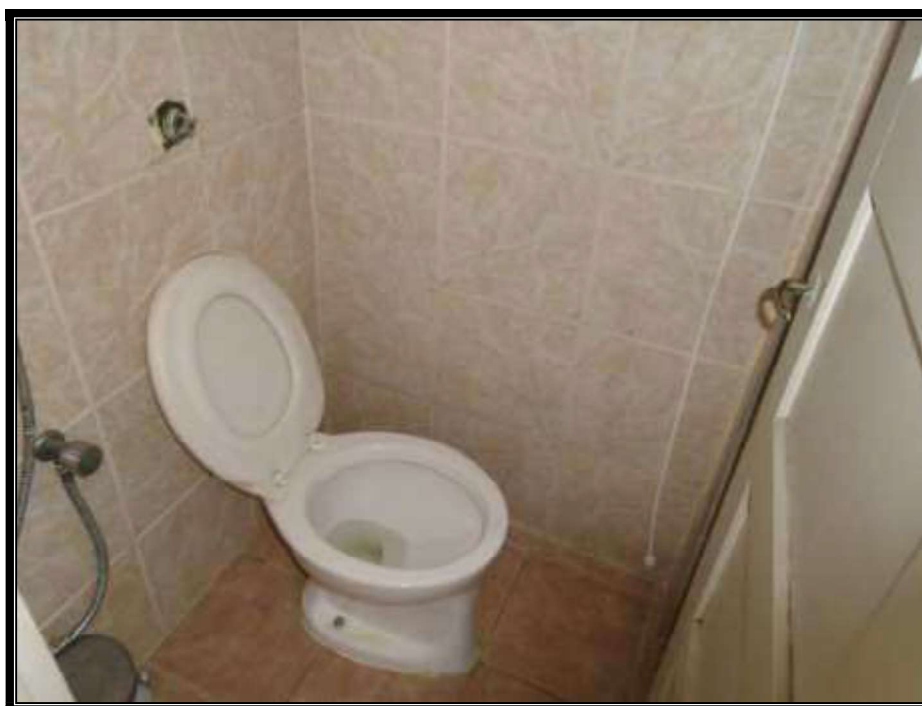
Vista parcial do WC de empregada.
