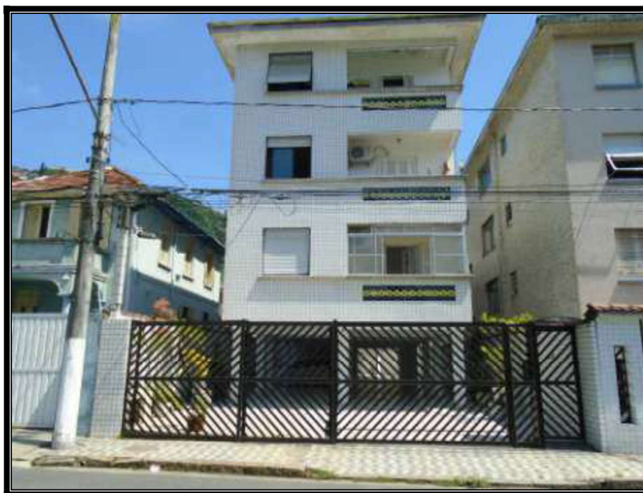
Vista parcial do edifício.
