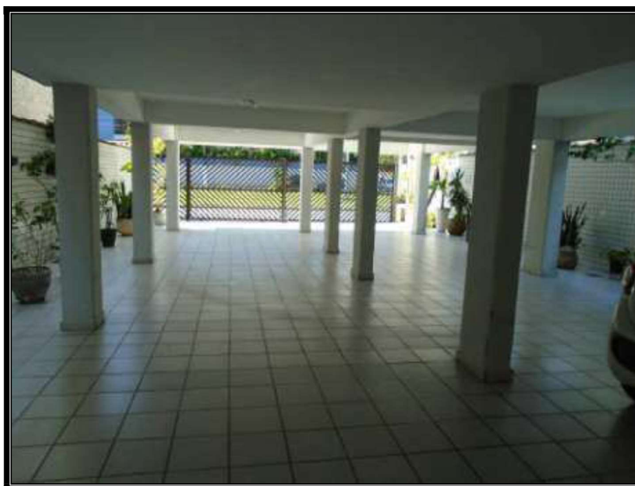
Vista parcial do estacionamento.
