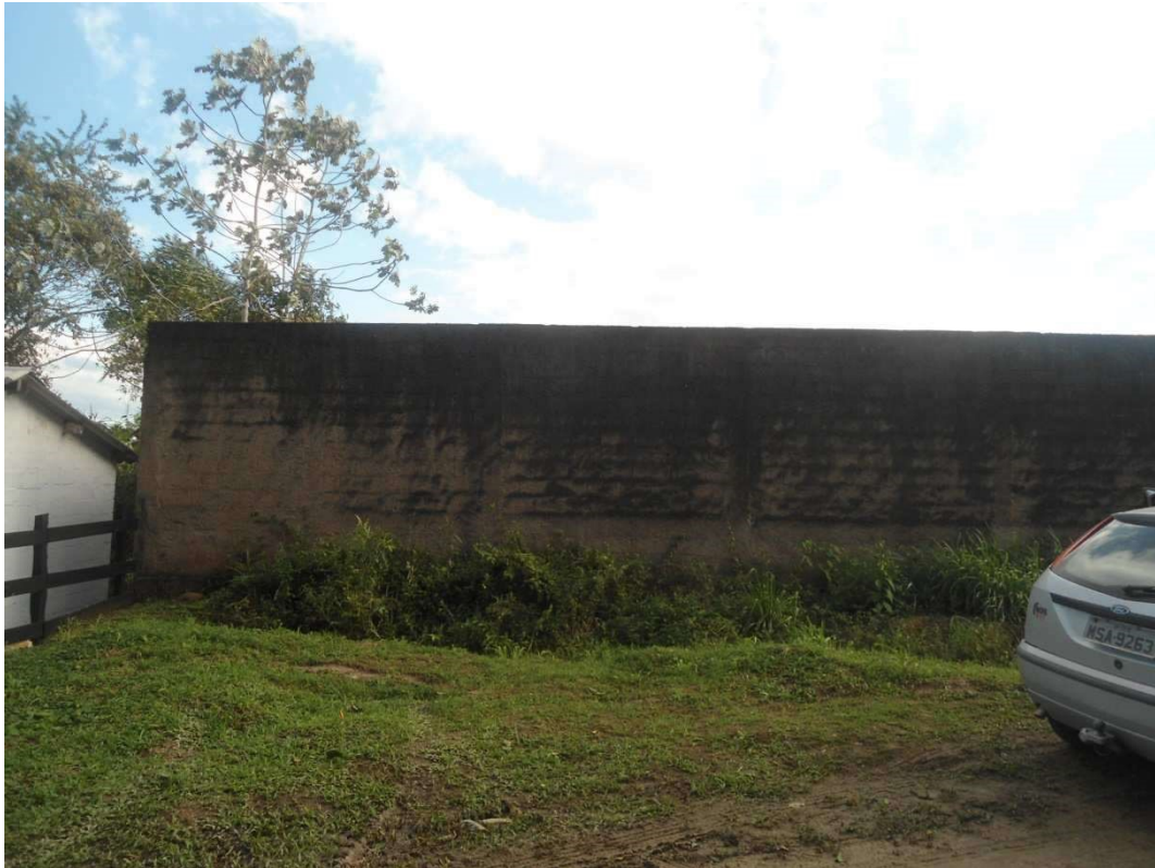
Muro existente na Rua nº 2, Ponto de GPS nº 5 (foto 5);
