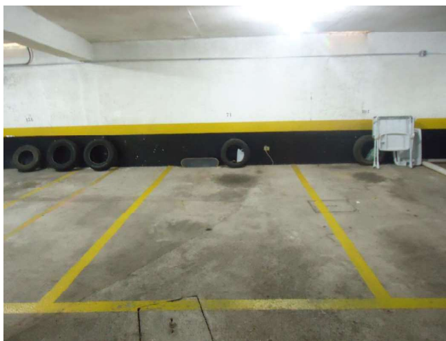
VISTA DA VAGA DE GARAGEM PERTENCENTE A UNIDADE AVALIANDA.
