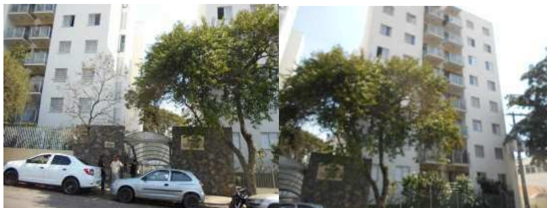
Fotos 02/03 – Vistas parciais externas do Condomínio onde se situada a imóvel sub-judice
