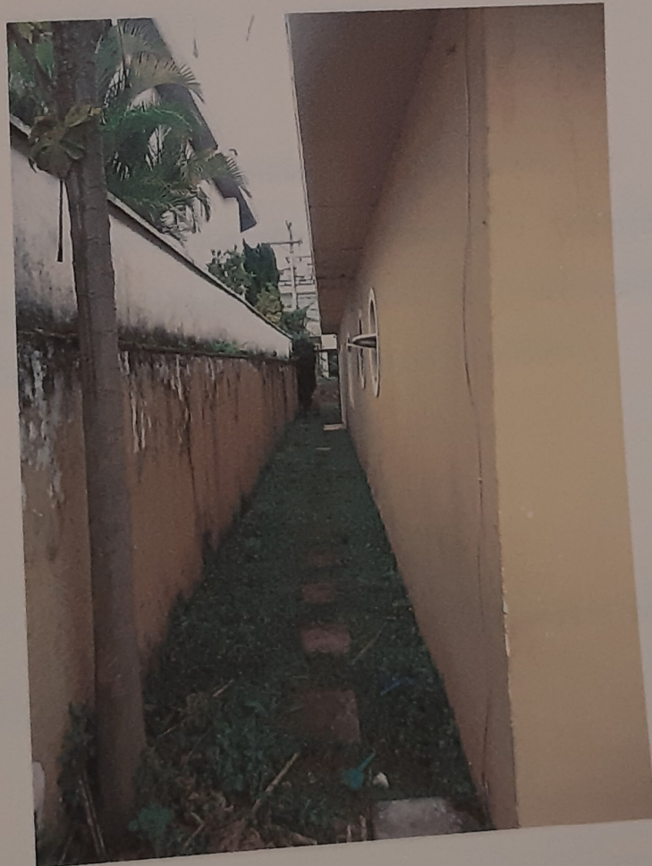
VISTA DO CORREDOR LATERAL.
