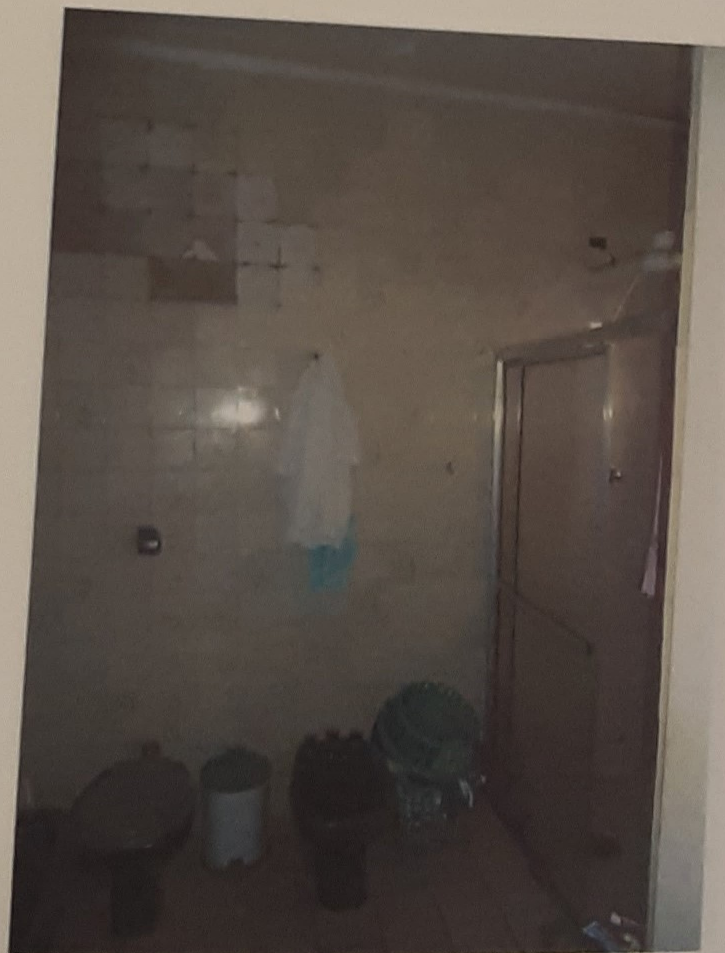
VISTA DO BANHEIRO DO PRIMEIRO DORMITÓRIO.
