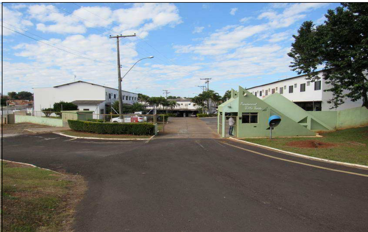
FOTO 01 – Vista frontal do condomínio residencial Villa Verde
