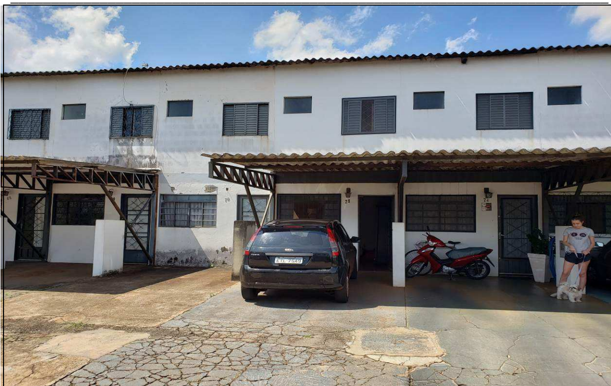
FOTO 03 – Vista frontal do imóvel nº 71 (imóvel avaliando).
