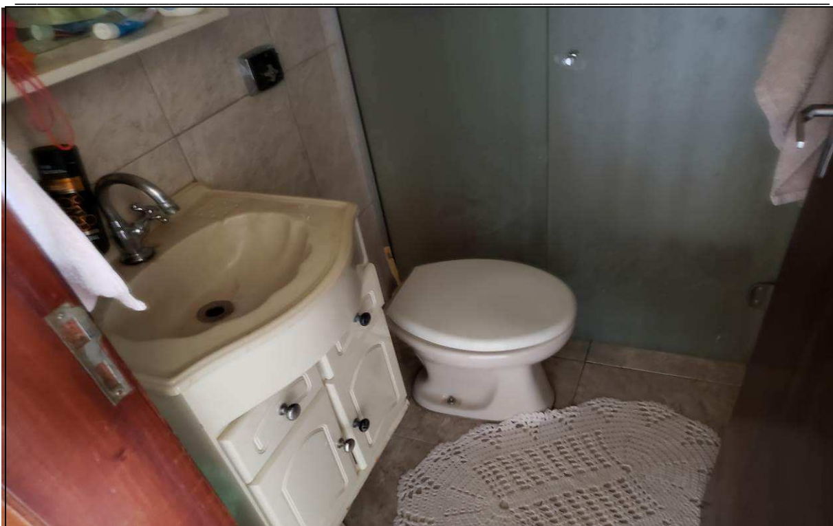
FOTO 09 – Vista geral do banheiro com lavatório, vaso sanitário e paredes azulejadas no piso superior.
