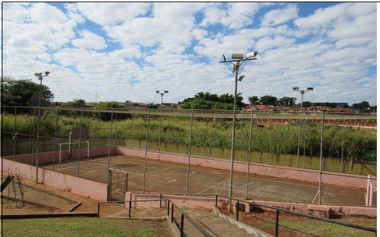
FOTO 12 – Vista geral da quadra poliesportiva no Condomínio Residencial Villa Verde.
