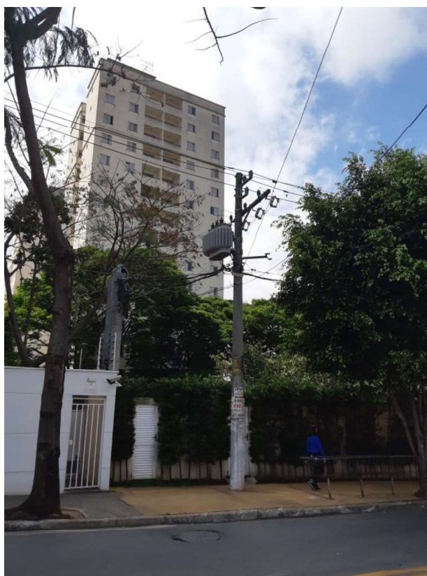
Bloco 1 – Edifício FAU no detalhe.
