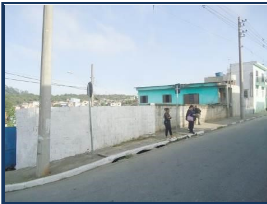
Vista da frente dos imóveis avaliados.
