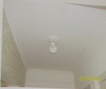
- Corredor de circulação
