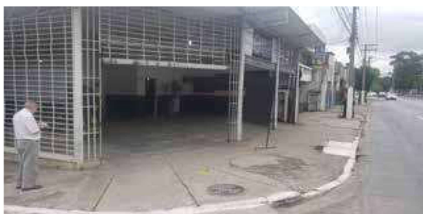
Imóvel nro 1.048 - vista externa da oficina
