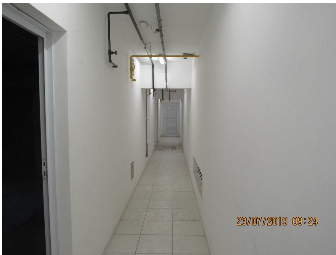
Imagem 24: 4º pavimento – corredor de serviços aos fundos da loja LJ414
