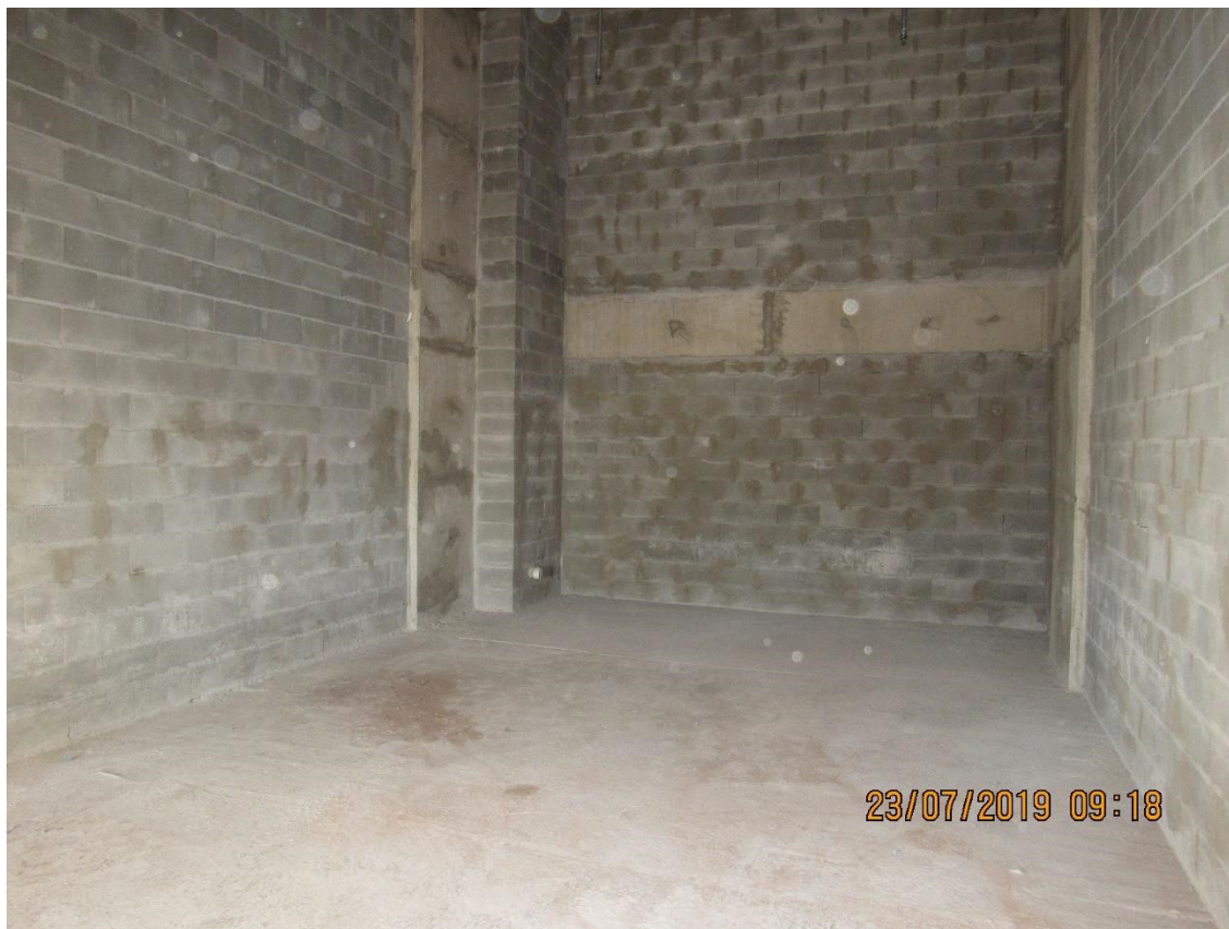
Imagem 19: 2° pavimento – vista interna da loja avalianda LJ212
