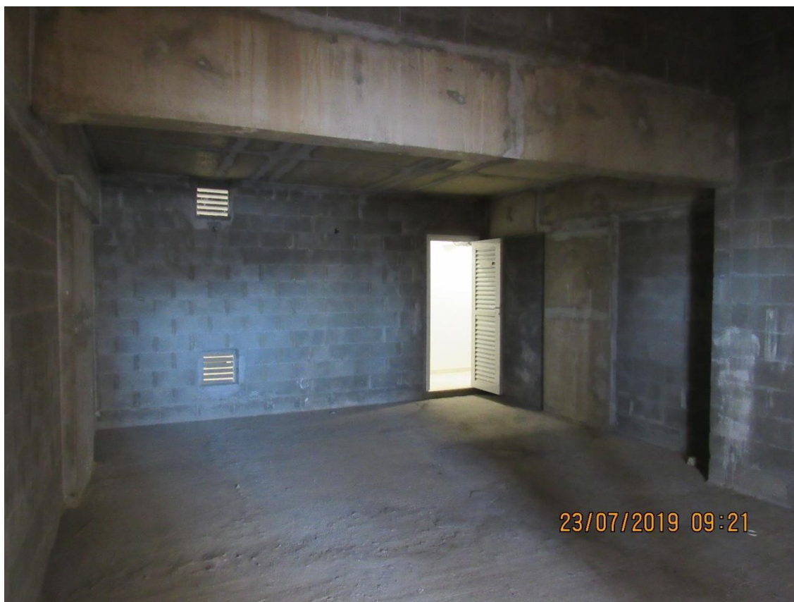
Imagem 23: 4° pavimento – vista interna da loja avalianda LJ414
