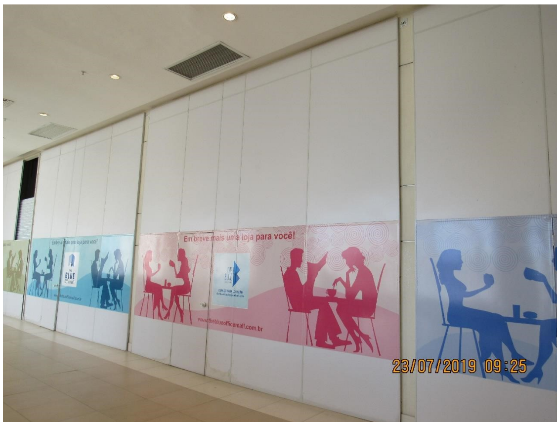
Imagem 21: 4º pavimento – vista da loja avalianda LJ414
