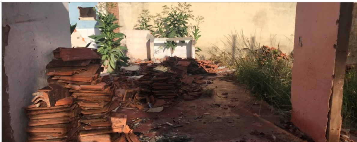
Imagem 05 – Vista do meio do terreno.
