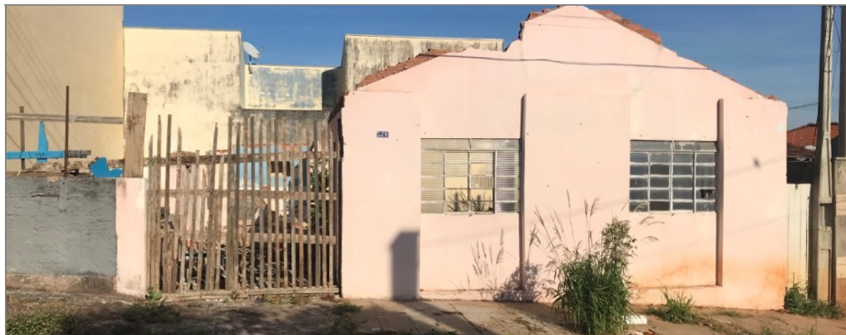
Imagem 02 – Ilustra fachada do imóvel para a Rua Dr. Gelás.
