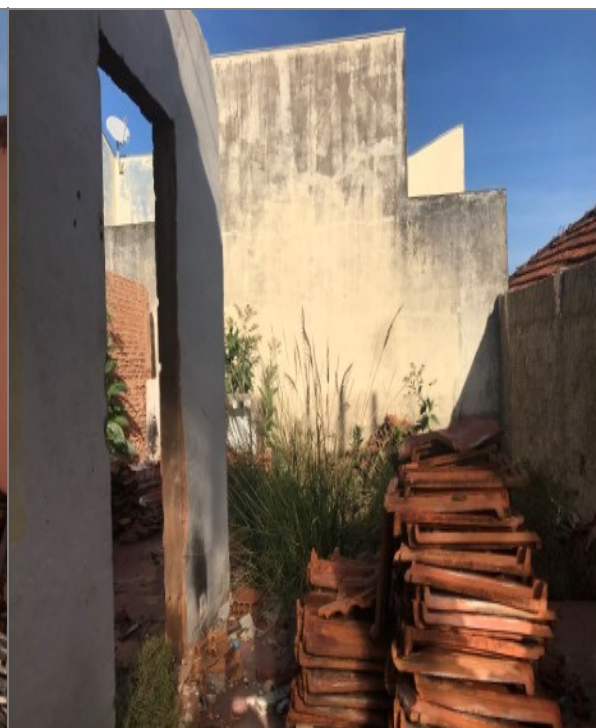
Imagem 04 – Vista lateral esquerda.
