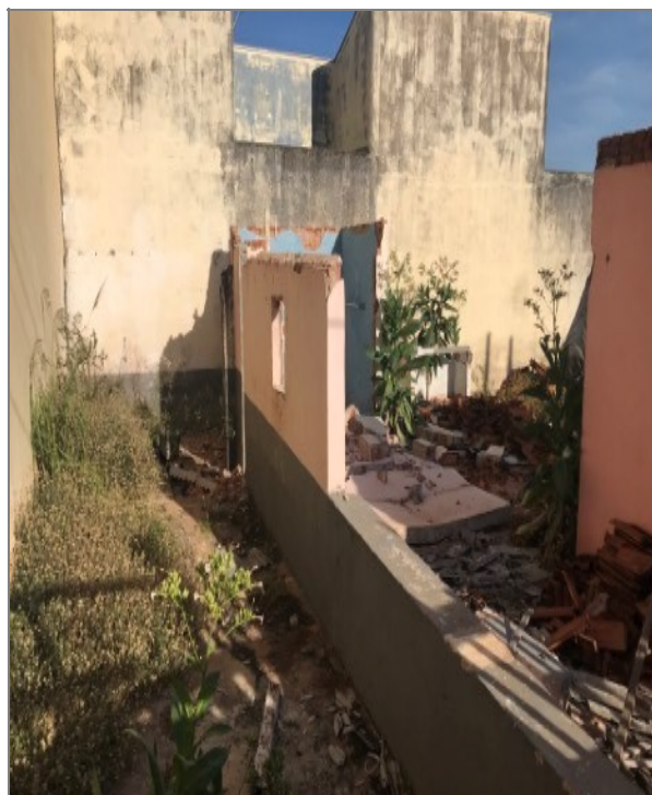
Imagem 03 – Trata-se de terreno com escombros. Vista lateral direita.
