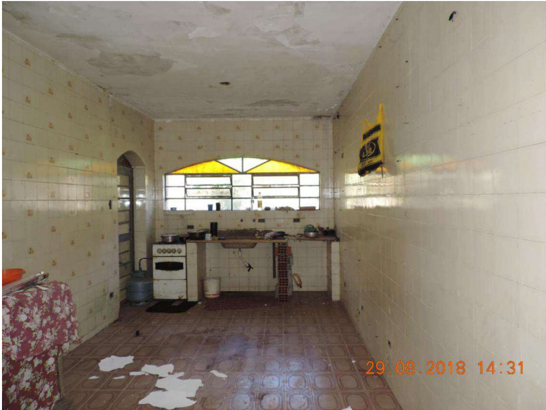
FOTO Nº 19 – VISTA INTERNA DA CASA SEDE (COZINHA)
