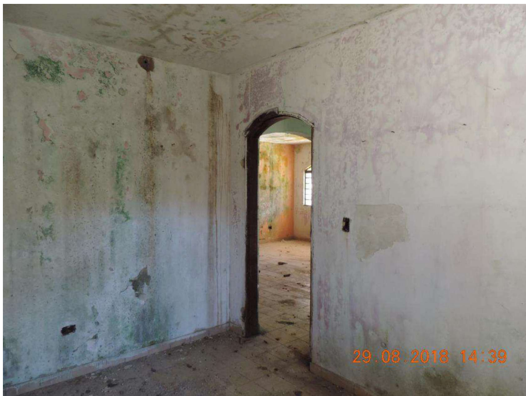
FOTO Nº 44 – VISTA INTERNA DA “CASA DE HÓSPEDES”
