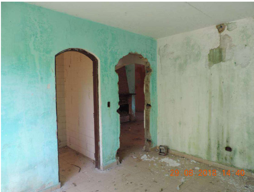
FOTO Nº 46 – VISTA INTERNA DA “CASA DE HÓSPEDES”
