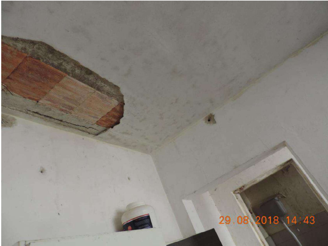
FOTO N° 53 – VISTA INTERNA DA “CASA DO CASEIRO”
