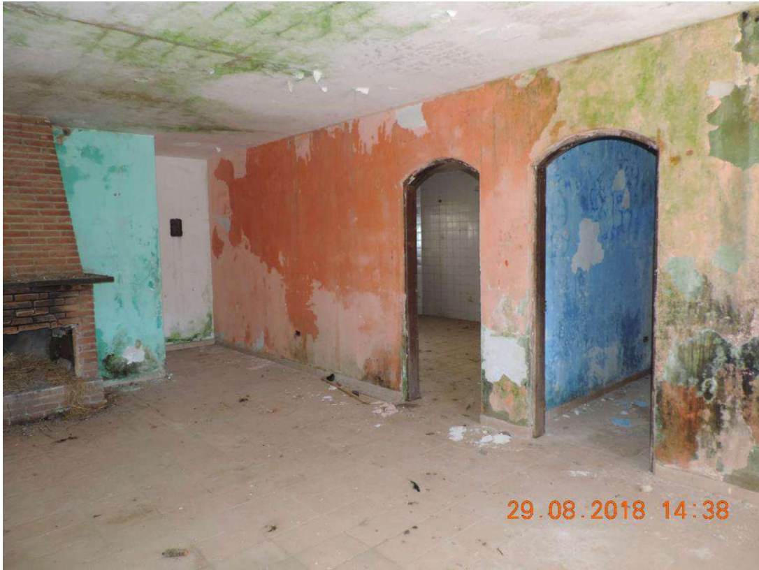
FOTO Nº 39 – VISTA INTERNA DA “CASA DE HÓSPEDES”
