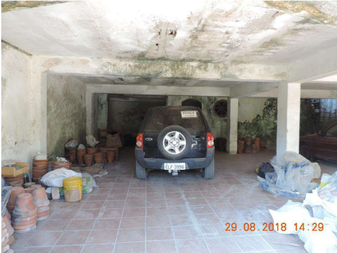
FOTO Nº 11 – GARAGEM DA “CASA SEDE”
