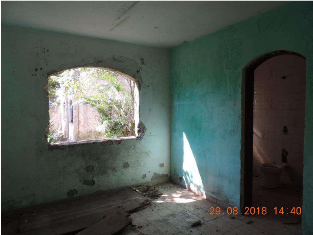
FOTO Nº 45 – VISTA INTERNA DA “CASA DE HÓSPEDES”
