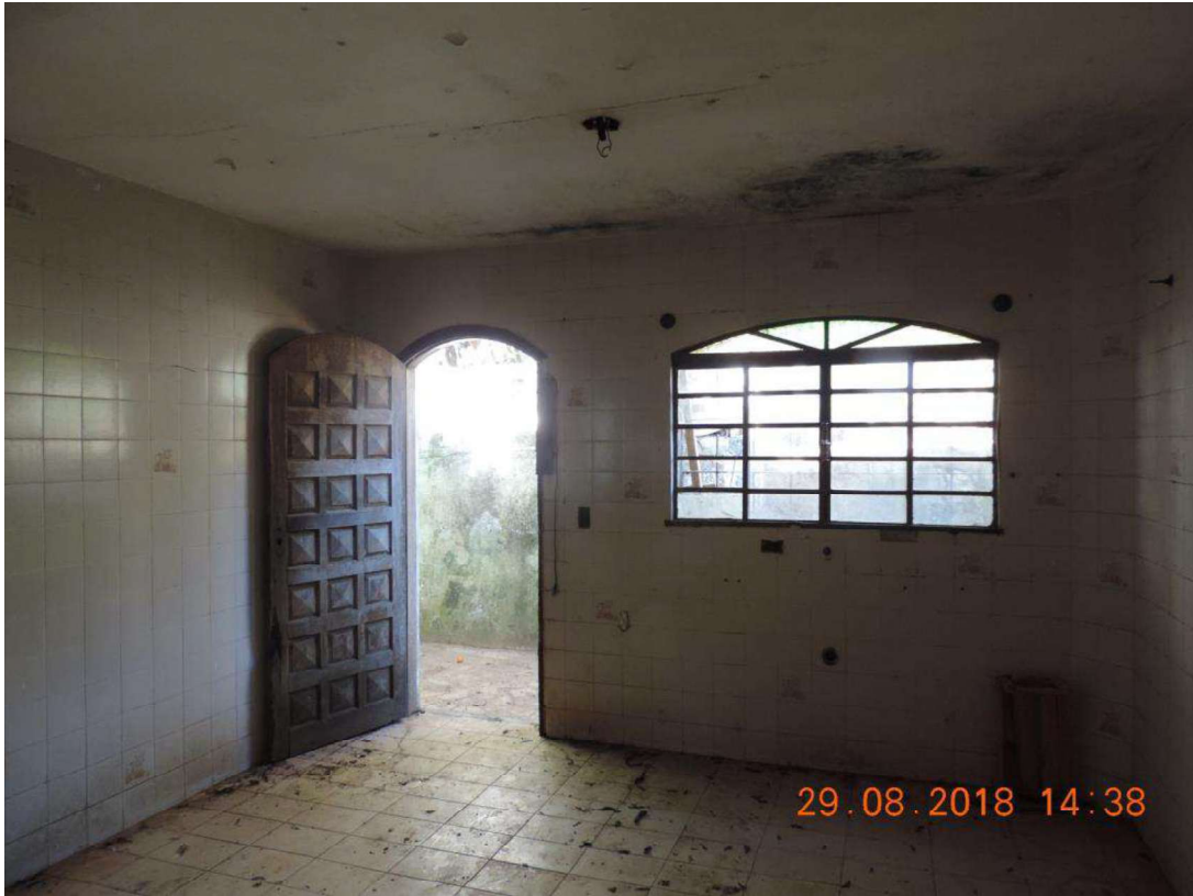
FOTO Nº 37 – VISTA INTERNA DA “CASA DE HÓSPEDES”
