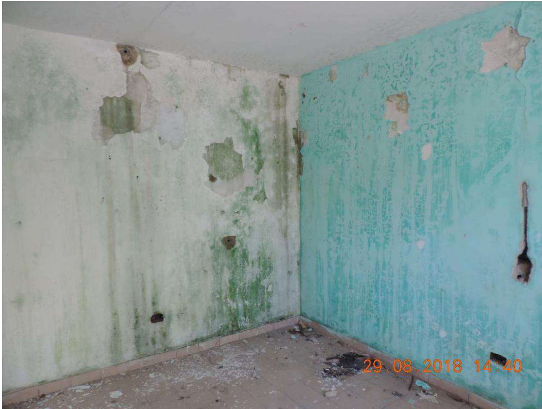
FOTO Nº 47 – VISTA INTERNA DA “CASA DE HÓSPEDES”
