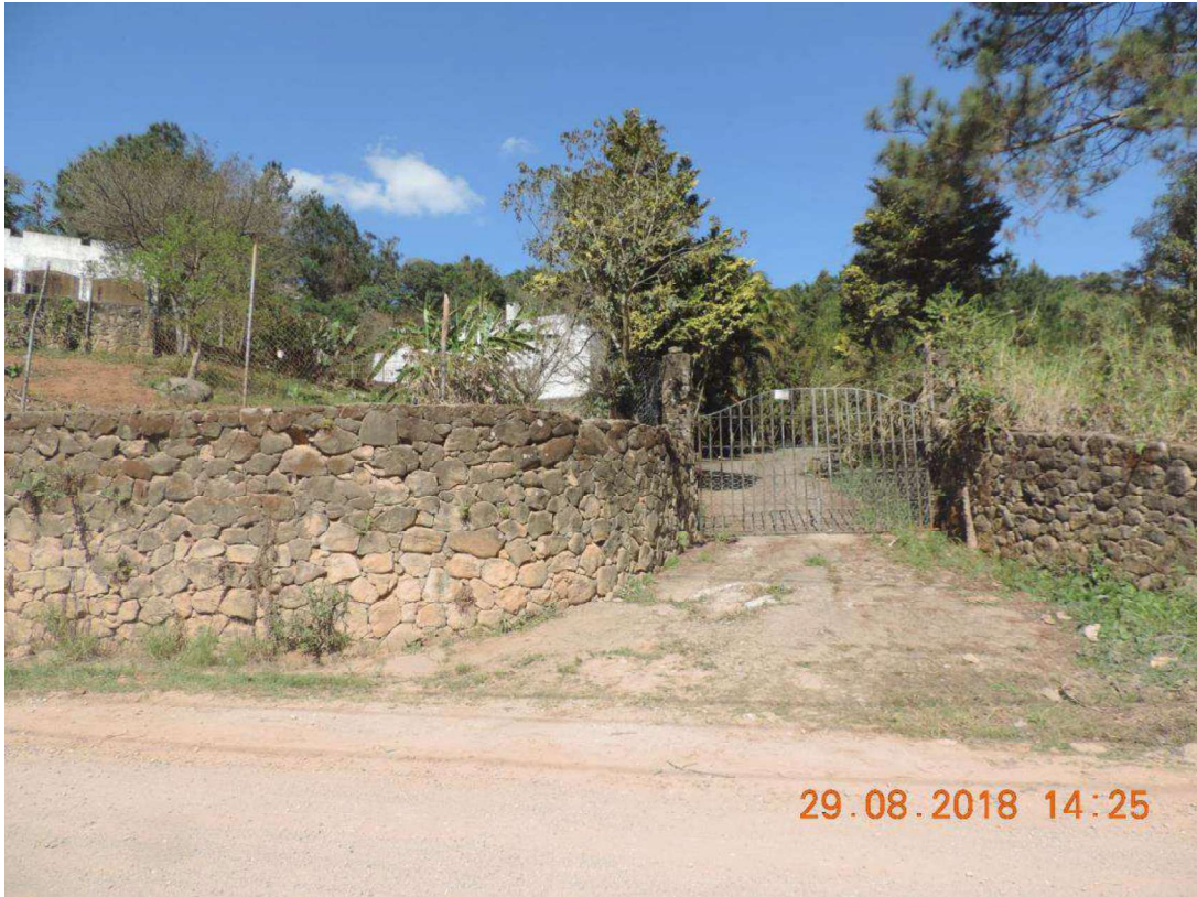
FOTO N° 03 – PORTÃO DE ACESSO DA PROPRIEDADE
