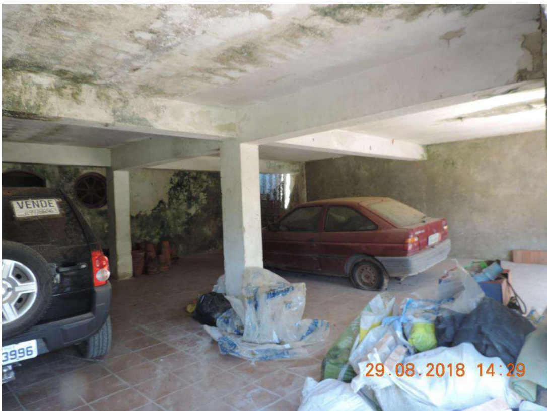
FOTO Nº 12 – GARAGEM DA “CASA SEDE”
