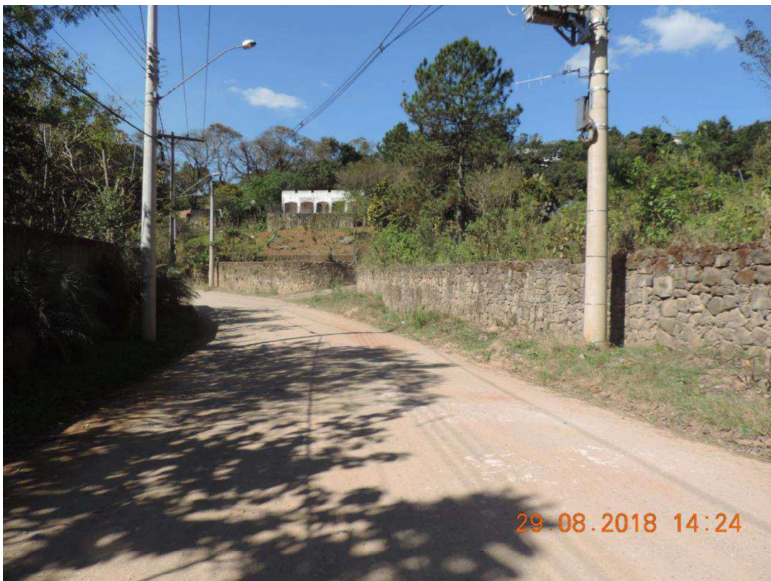
FOTO Nº 02 – RUA ANTÔNIO DA CUNHA LEITE (IMÓVEL AVALIANDO A DIREITA)
