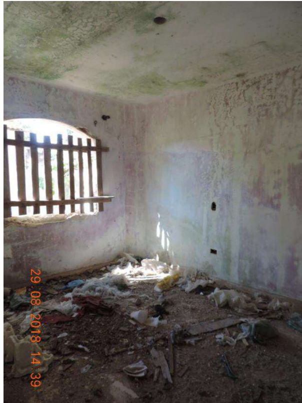
FOTO Nº 43 – VISTA INTERNA DA “CASA DE HÓSPEDES”
