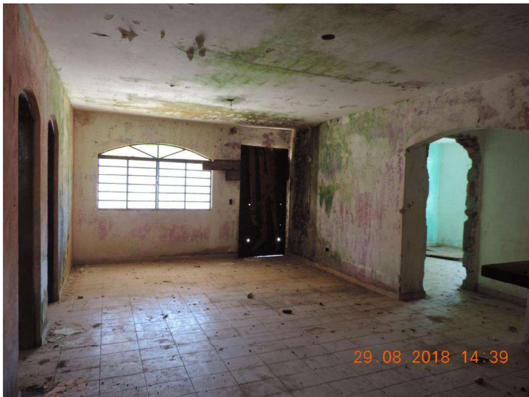
FOTO Nº 42 – VISTA INTERNA DA “CASA DE HÓSPEDES”
