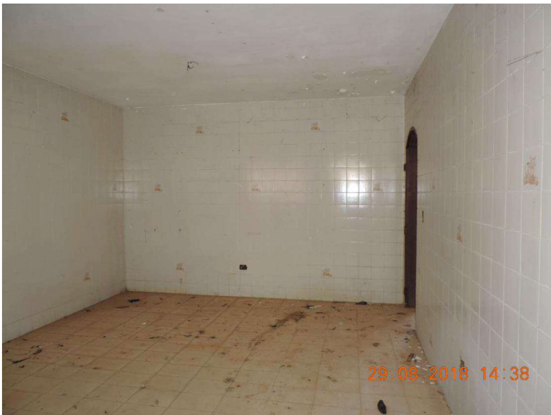
FOTO Nº 36 – VISTA INTERNA DA “CASA DE HÓSPEDES”
