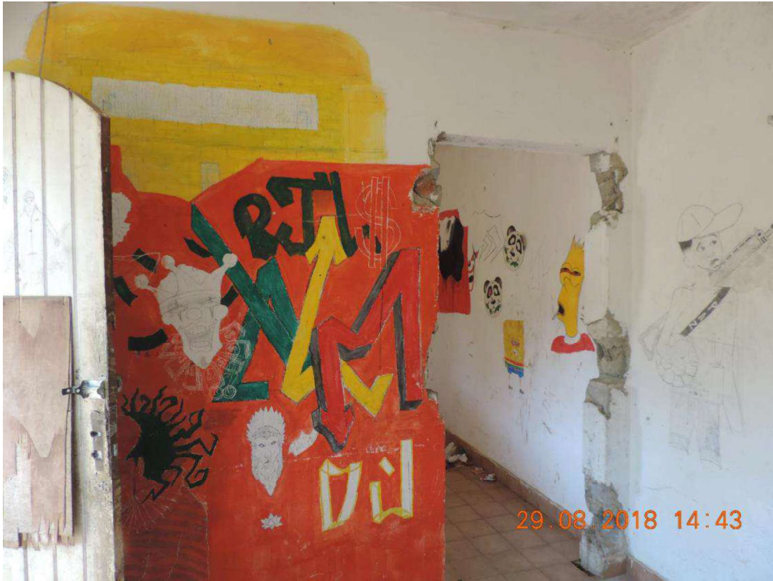
FOTO Nº 51 – VISTA INTERNA DA “CASA DO CASEIRO”
