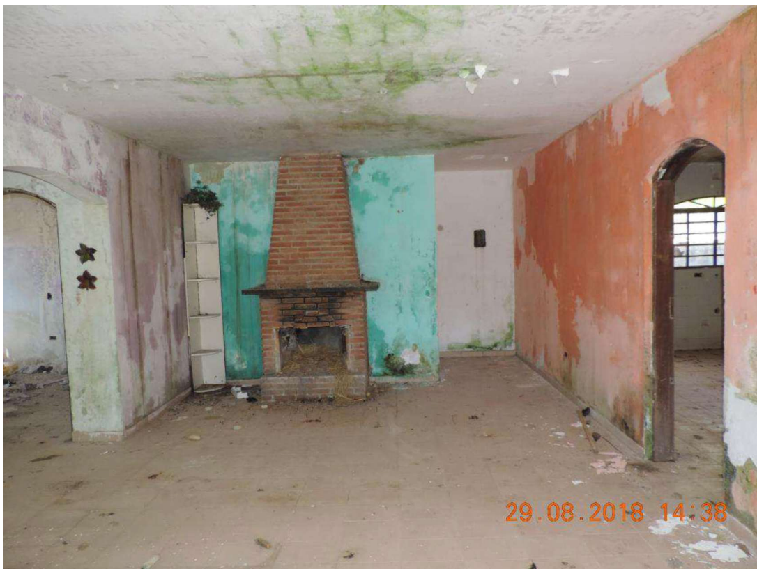
FOTO Nº 38 – VISTA INTERNA DA “CASA DE HÓSPEDES”
