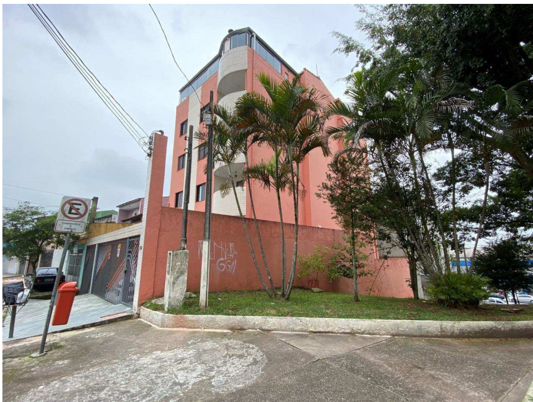
Foto 02: Fachada lateral do edifício desde a Rua Nicola Feltrin.
