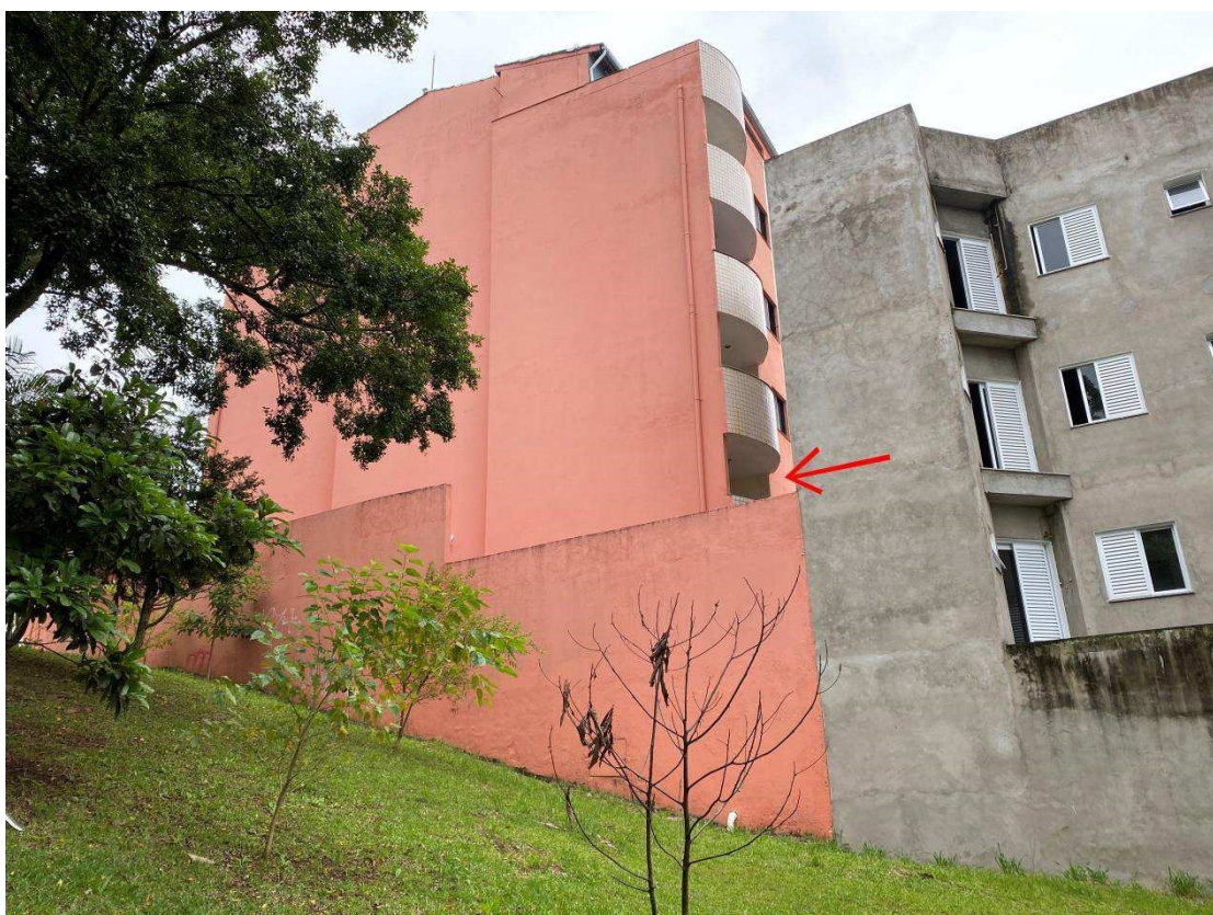
Foto 06: Vista lateral do Edifício com varanda do apartamento avaliando indicada.
