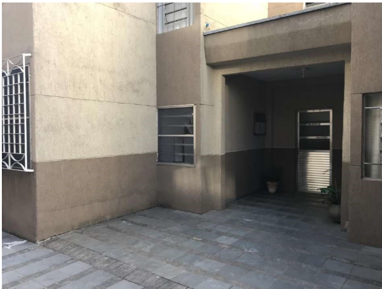
HALL DE ACESSO AO BLOCO "G"
