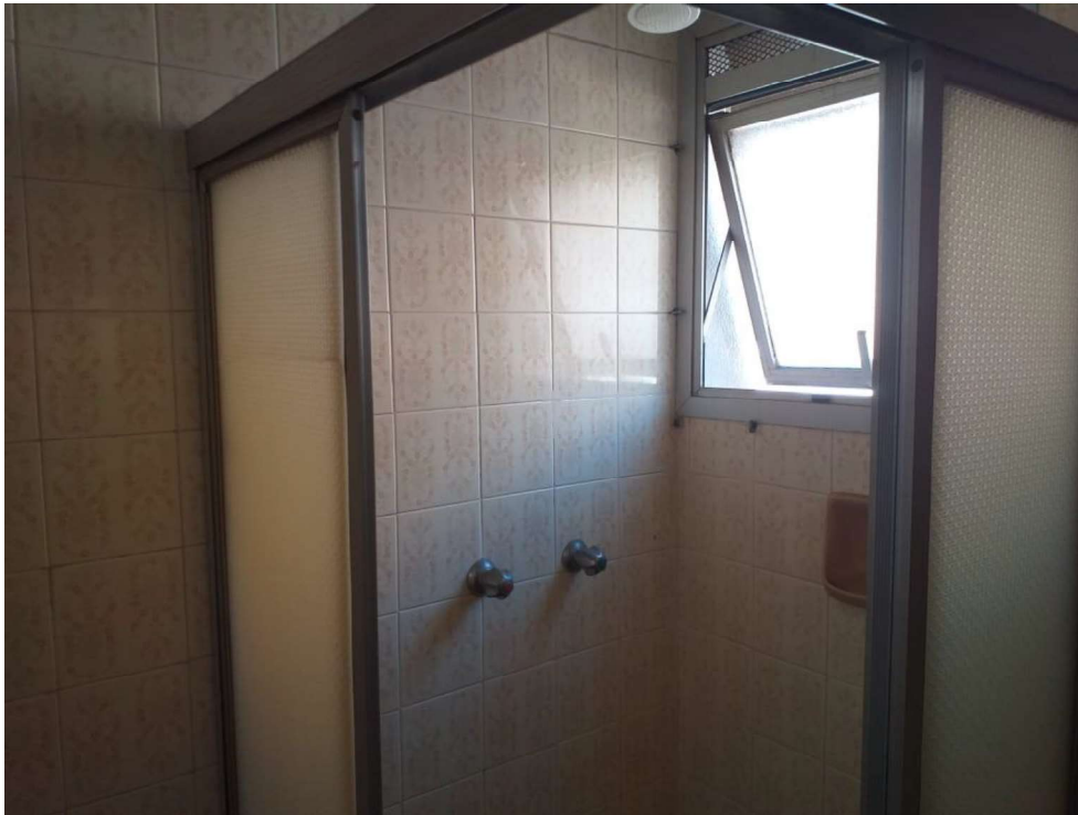
Idem, notando o box em acrílico e esquadrias de alumínio.
