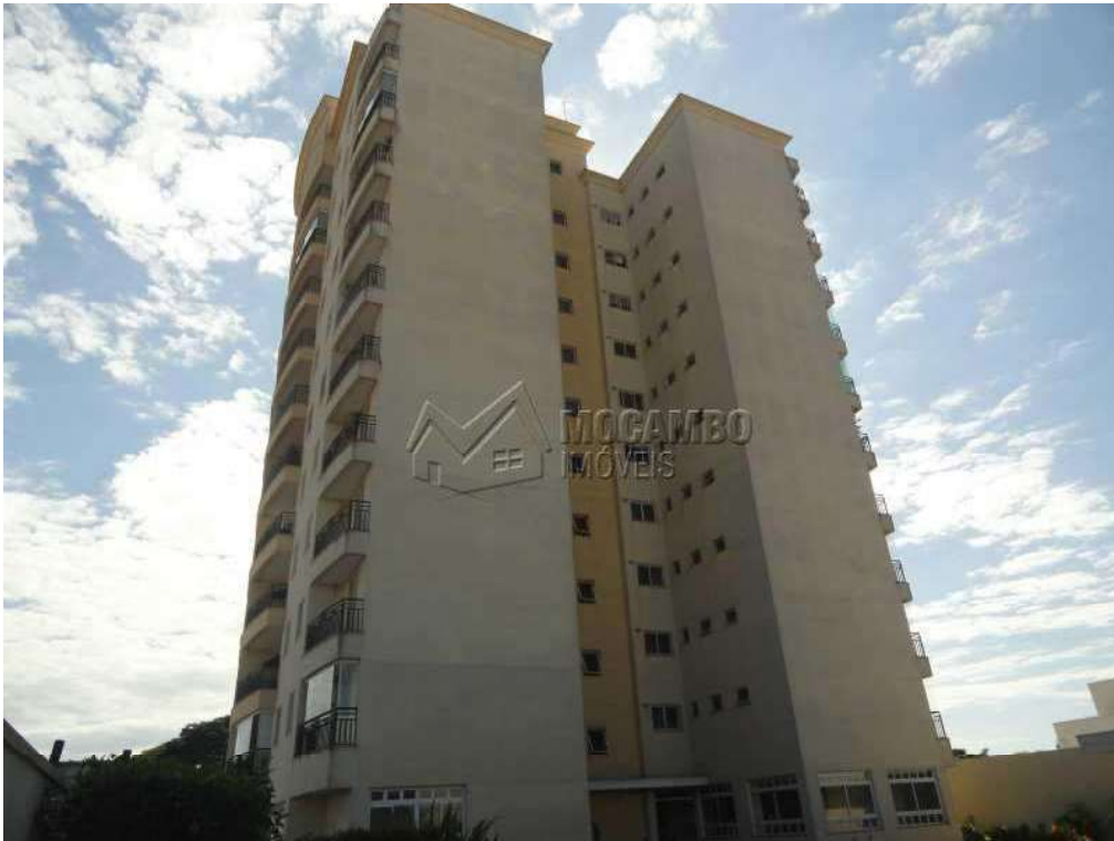
(Foto 1 - Fachada do Edifício)
