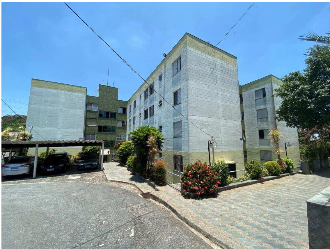
Foto 05: Vista de dois blocos do Condomínio.
