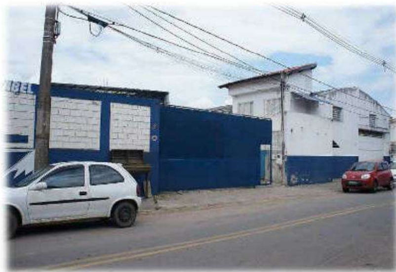
Vista do frontispício do imóvel avaliando, tomada pela via acima citada.
