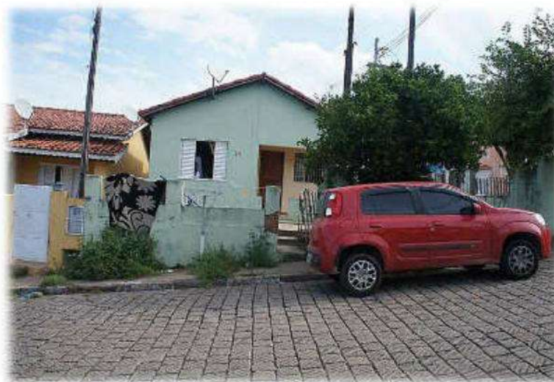
Vista do frontispício do imóvel avaliando, tomada pela via acima citada.
