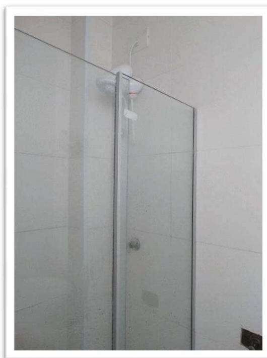
Foto nº 41 - Outra vista parcial interna do banheiro junto à lavanderia, no imóvel objeto da presente vistoria. Em destaque box em vidro temperado.
