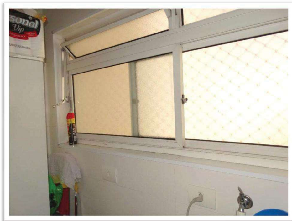
Foto nº 38 - Vista parcial da lavanderia, junto à cozinha, no imóvel objeto da presente vistoria. Em destaque esquadria em alumínio e vidro.
