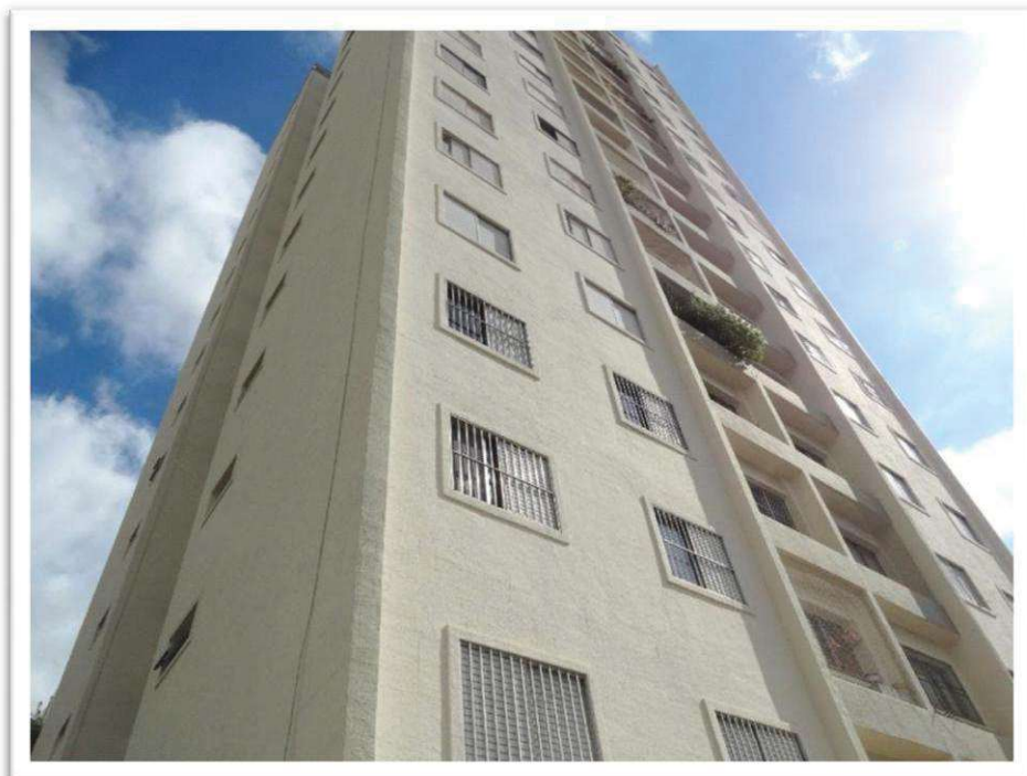
Foto nº 55 - Aspectos da fachada lateral do “EDIFÍCIO BASE DAS CANOAS”.
