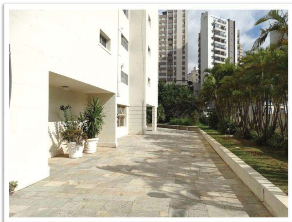
Foto nº 57 - Aspectos gerais externos do “EDIFÍCIO BASE DAS CANOAS”.
