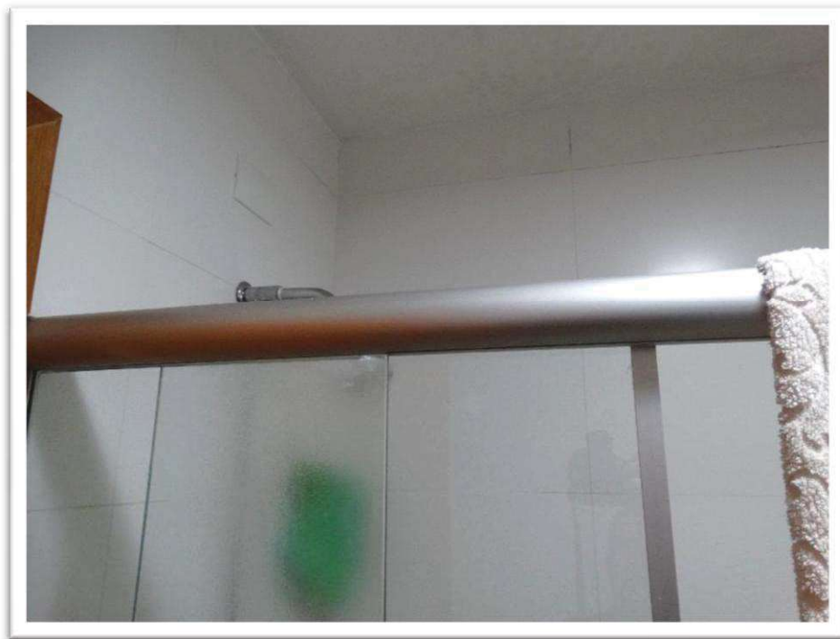
Foto nº 32 - Vista parcial do banheiro social do imóvel objeto da presente vistoria. Em destaque estrutura do box em vidro e alumínio.
