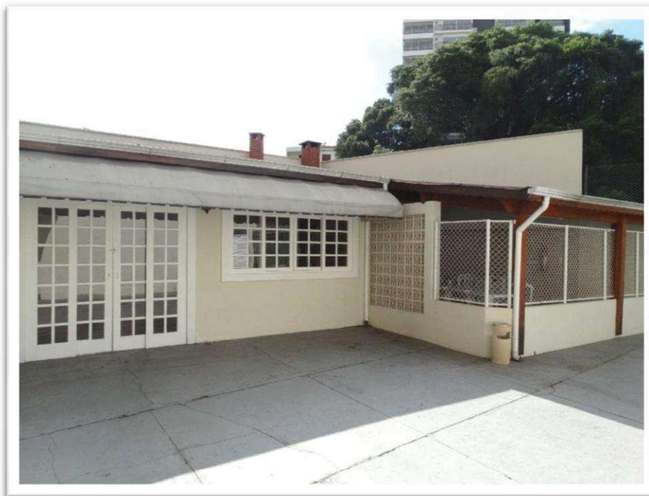
Foto nº 58 - Aspectos gerais externos do “EDIFÍCIO BASE DAS CANOAS”- Salão de Festas e Churrasqueira.
