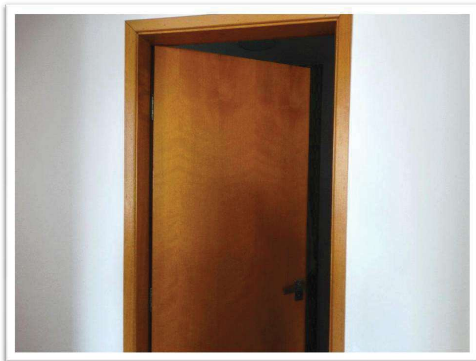
Foto nº 30 - Vista da porta de acesso ao banheiro social a partir do hall de distribuição na área íntima do imóvel objeto da presente vistoria.
