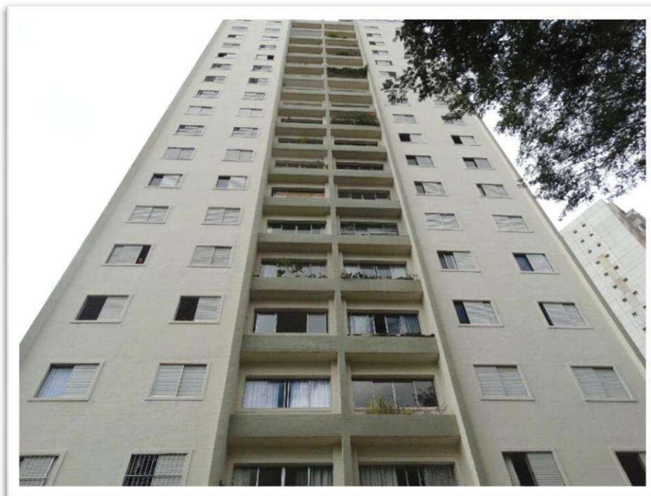
Foto nº 52 - Aspectos da fachada frontal do “EDIFÍCIO BASE DAS CANOAS”.
