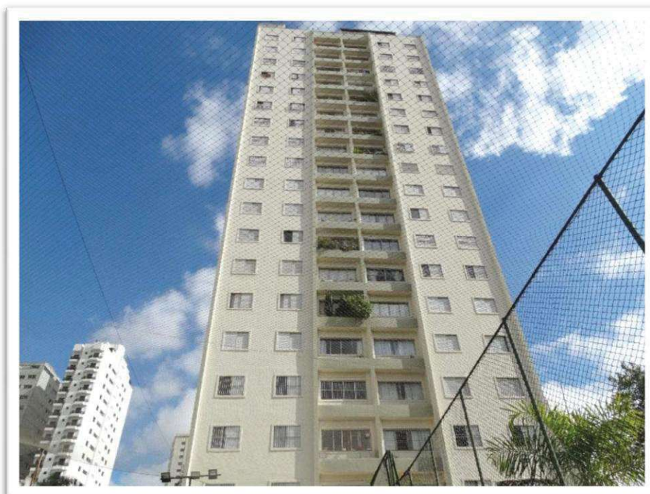
Foto nº 53 - Aspectos da fachada de fundo do “EDIFÍCIO BASE DAS CANOAS”.
