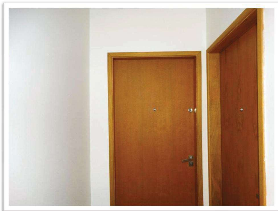
Foto nº 10 - Vista das portas de entrada, social e de serviço, do apartamento de nº 154 do “EDIFÍCIO BASE DAS CANOAS” , objeto da presente vistoria.
