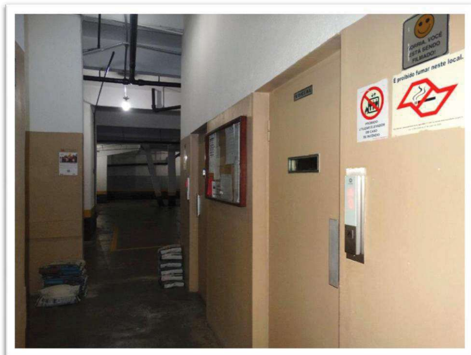
Foto nº 45 - Vista do hall de elevadores, no 2º subsolo do “EDIFÍCIO BASE DAS CANOAS”.
