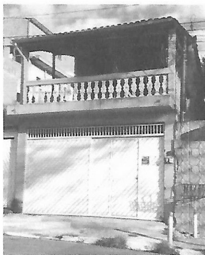
Foto 1: Frente do imóvel
