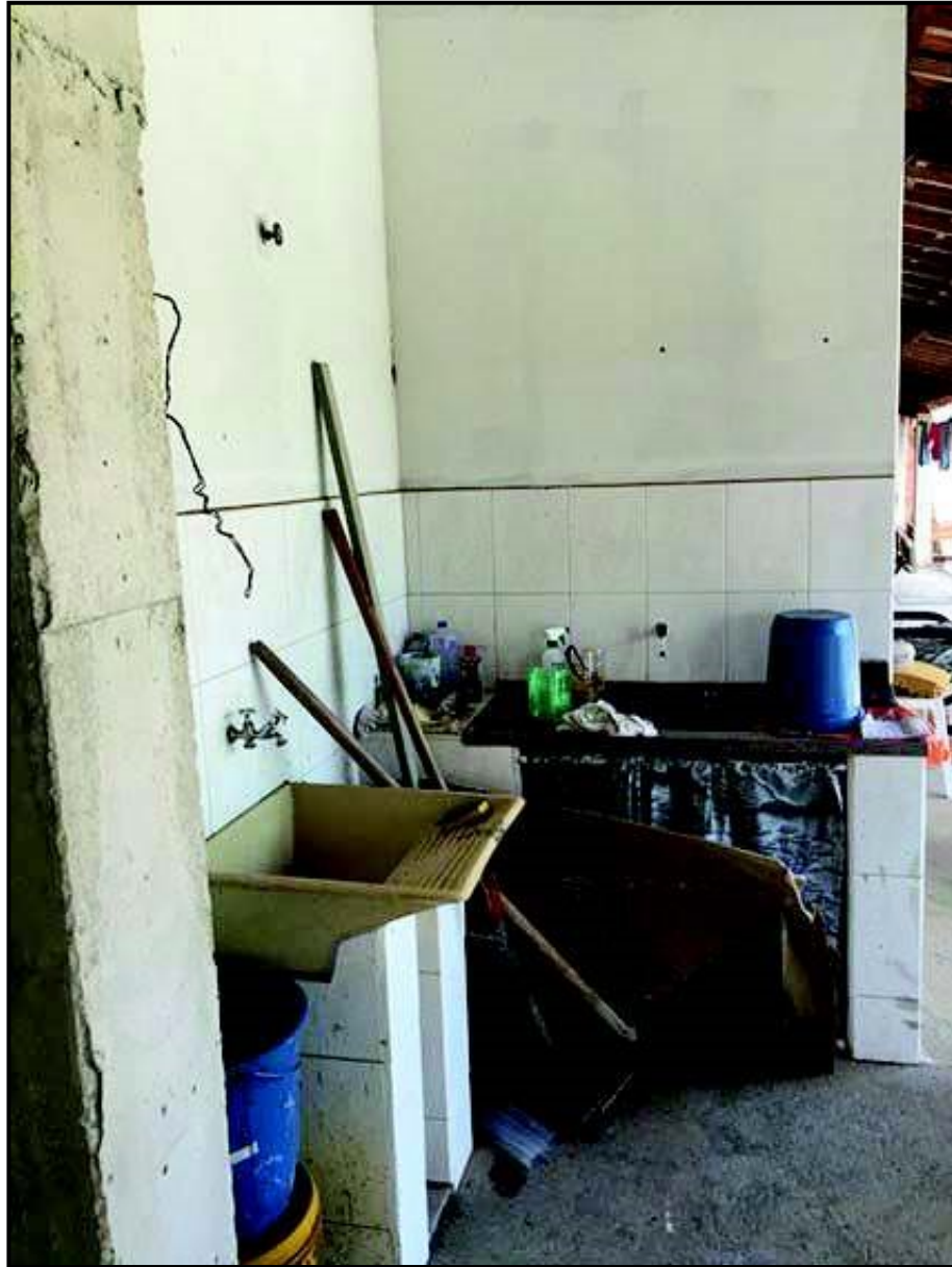
VISTA DA LAVANDERIA - EDÍCULA
