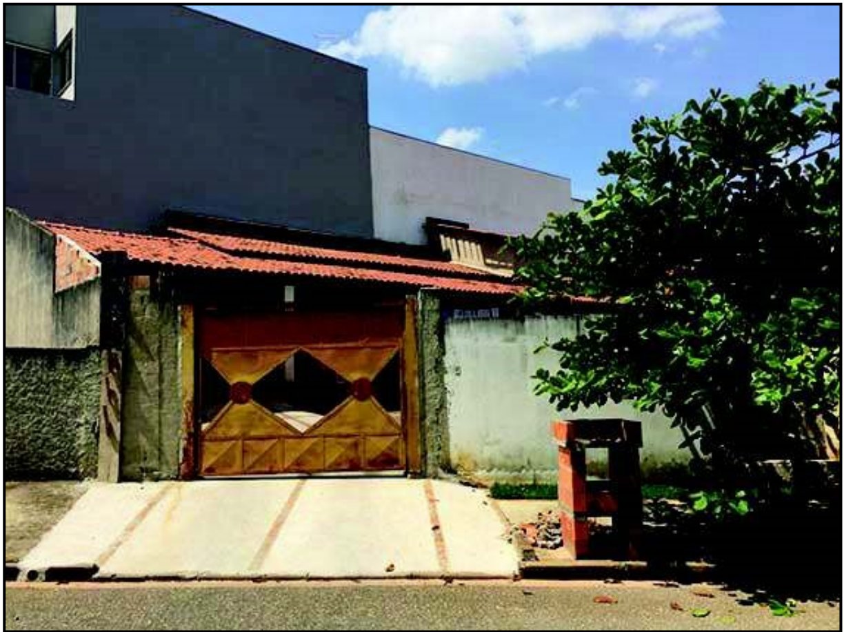
VISTA DA FACHADA DO IMÓVEL AVALIANDO
