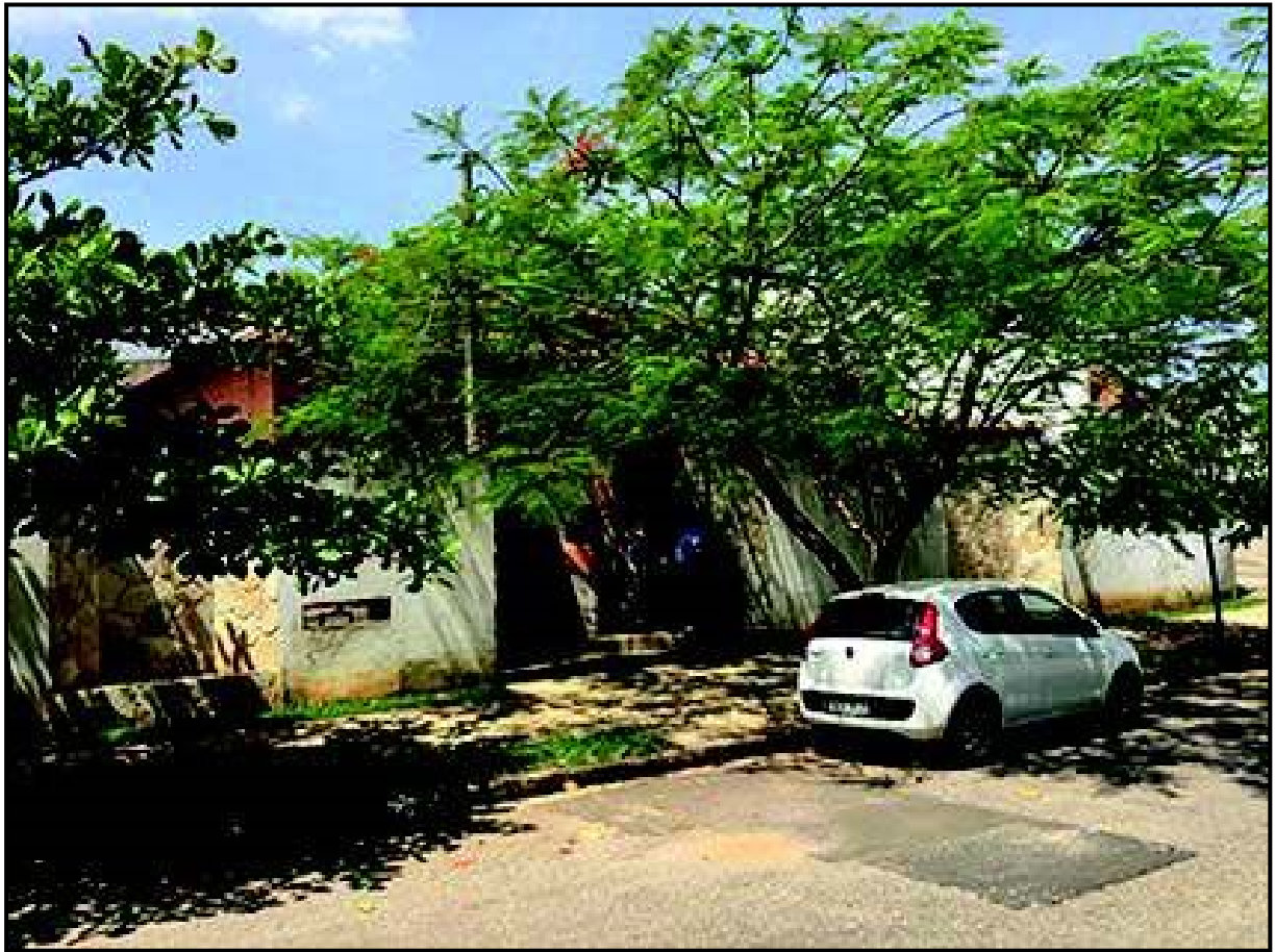
VISTA GERAL DA FACHADA DO IMÓVEL AVALIANDO
